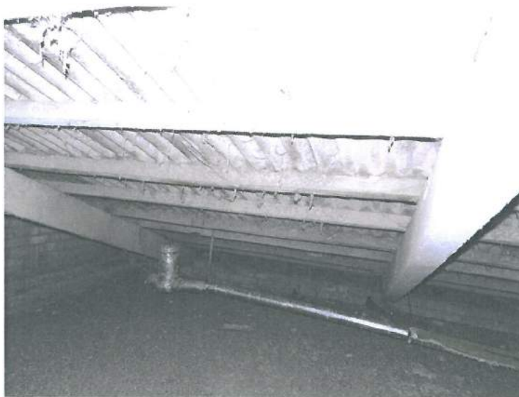
9.att Jumta konstrukcijas.
