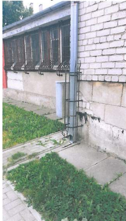
7.att. Horizontālā hidroizolācija. Ielas puse
