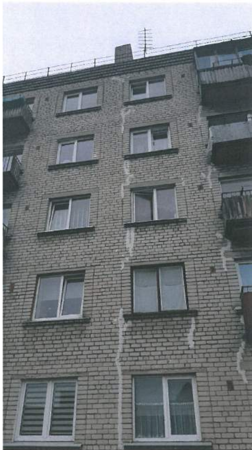
5.att Remontētas plaisas. Sētas puse.
