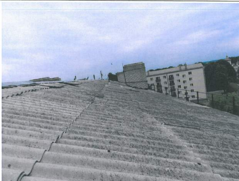
10.att Jumta segums.
