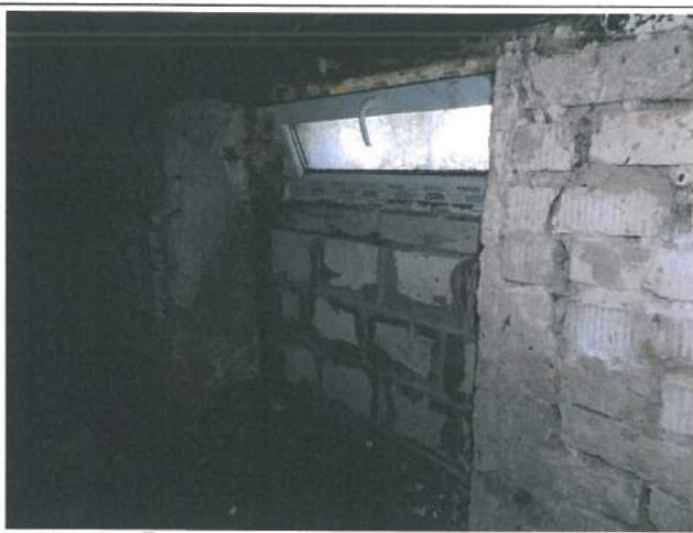
14.att. Ēkas austrumu puses pagraba lodziņš
