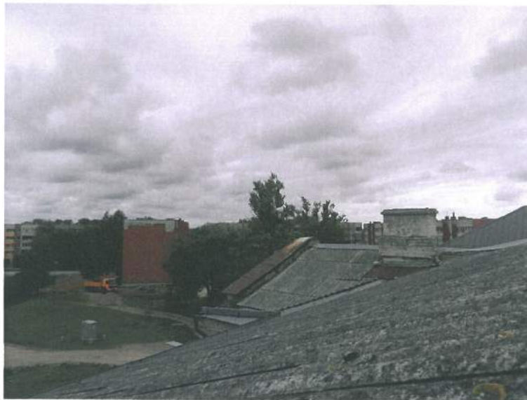
20.att Jumta segums
