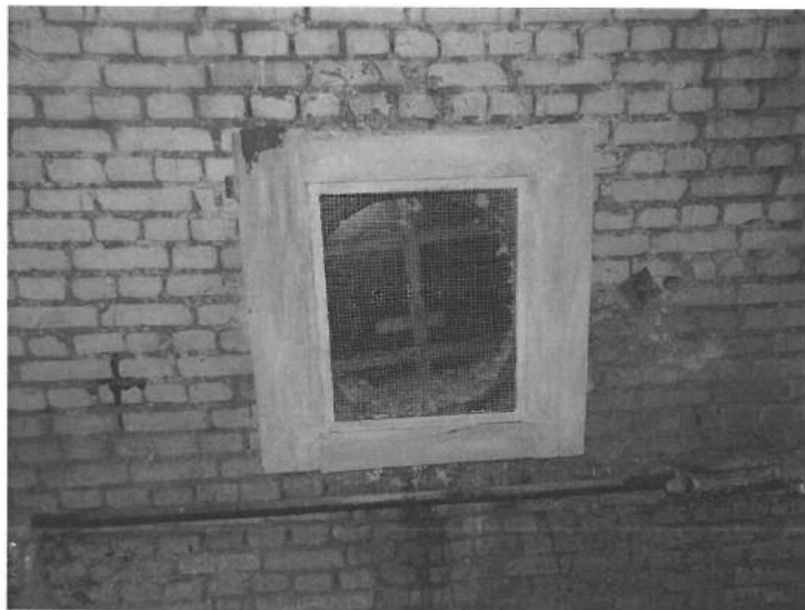
17.att. Bēniņu ventilācijas lodziņš
