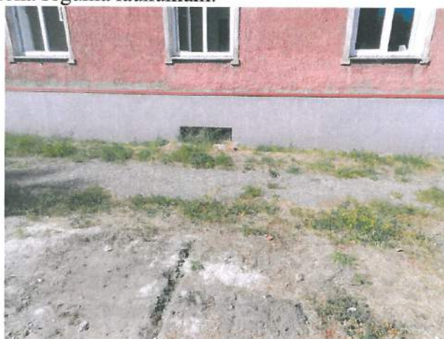
9.att. Izstrūkstosā lietusūdens apmale. Ielas puse
