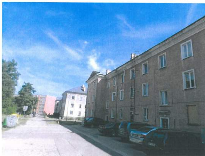
2. att. Apsekojamās ēkas sētas puse
