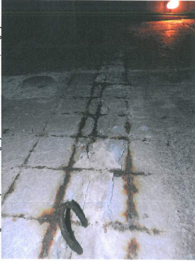
26.,27.att. Trijiem jumta paneļiem konstatēts kritisks tehniskais stāvoklis: pēc betona nobīšanas atsegts sarūsējis darba stiegrojums nesošo ribu vietās; stiegrojums izliecies.
