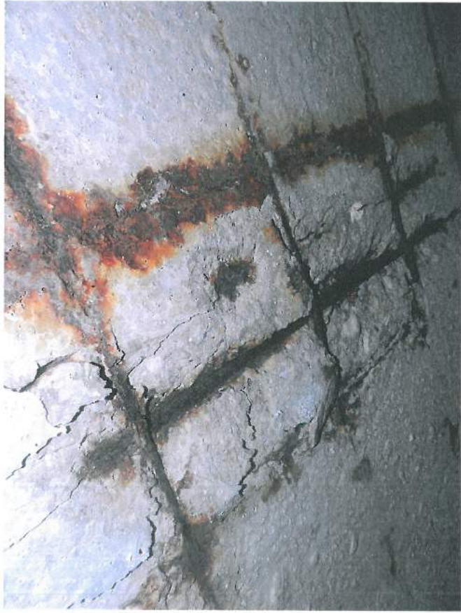
26.,27.att. Trijiem jumta paneļiem konstatēts kritisks tehniskais stāvoklis: pēc betona nobīšanas atsegts sarūsējis darba stiegrojums nesošo ribu vietās; stiegrojums izliecies.
