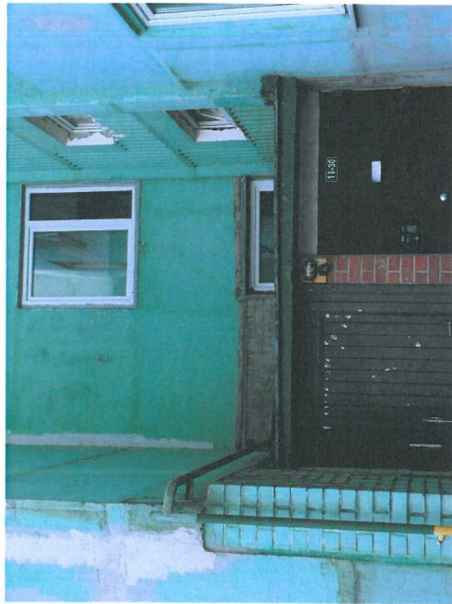
8., 9. att. Dzīvojamās mājas ārējo ieeju mezglu detaļas jāatjauno; ārdurvis ir nomainītas; 4. sekcijas jumtiņu vēlams pagarināt.
