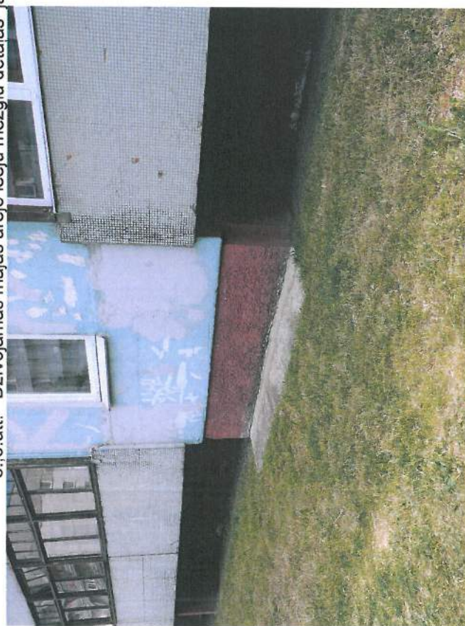
10., 11. att. Betona apmale ierīkota tikai pie izvirzītajām ārsienām. Pagraba ieejām jānomaina ārdurvis; jāatjauno pakāpienu un atbalstsienu virsma.
