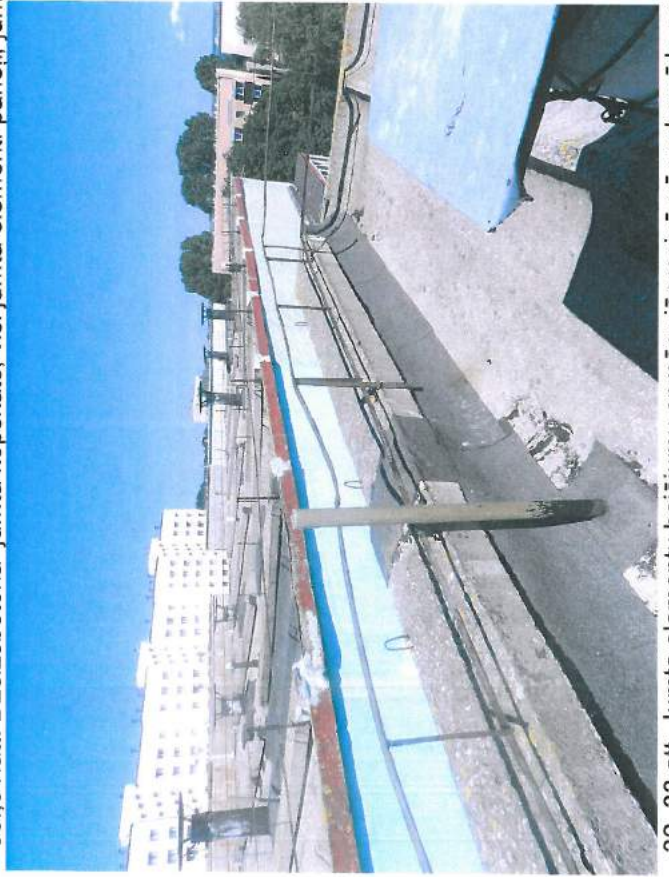
32.,33.att. Jumta elementu bojājumu apmēru jāprecizē pēc ruberoīda noņemšanas; apsekojumā konstatēti jauni bojājumi-plaisas, caurumi, stiegu atsegumi.
