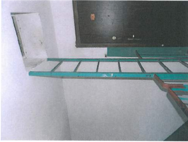
16., 17., 18. att. Ieejas bēniņos ierīkotas no visām kāpņu telpām caur lūku pārsegumā. Lūku vāki jānomaina uz ugunsdrošiem.
