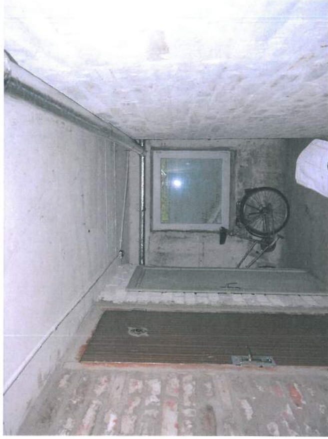
12., 13.att. Veicama pagraba pārseguma siltināšana, pagraba telpas tīras. Pagraba logi nomainīti. Šķūņšiem pārsvārā mūrētas sienas; to augšdaļa būs jādemontē.
