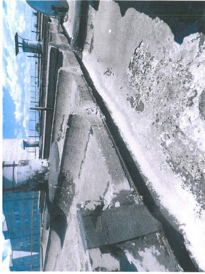
34., 35.att. Jumta tehnēs redzami betona virsmas bojājumi; lielākie defekti nosegti ar ruberoīdu. Jumtam jāveic augšējās virsmas remonts, hidroizolācijas atjaunošana.
