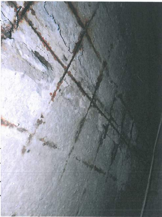
26.,27.att. Trijiem jumta paneļiem konstatēts kritisks tehniskais stāvoklis: pēc betona nobīšanas atsegts sarūsējis darba stiegrojums nesošo ribu vietās; stiegrojums izliecies.
