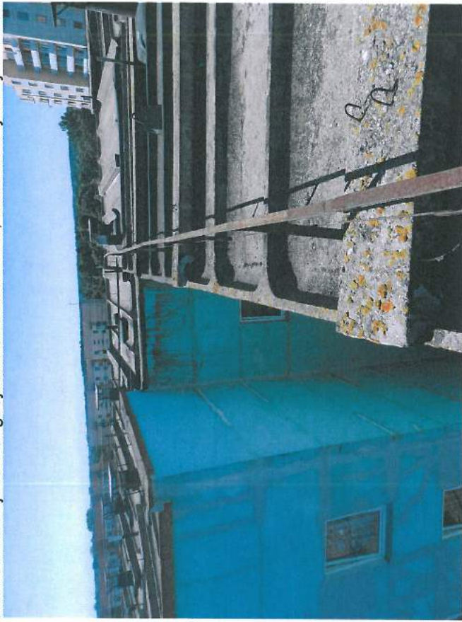
34., 35.att. Jumta tehnēs redzami betona virsmas bojājumi; lielākie defekti nosegti ar ruberoīdu. Jumtam jāveic augšējās virsmas remonts, hidroizolācijas atjaunošana.
