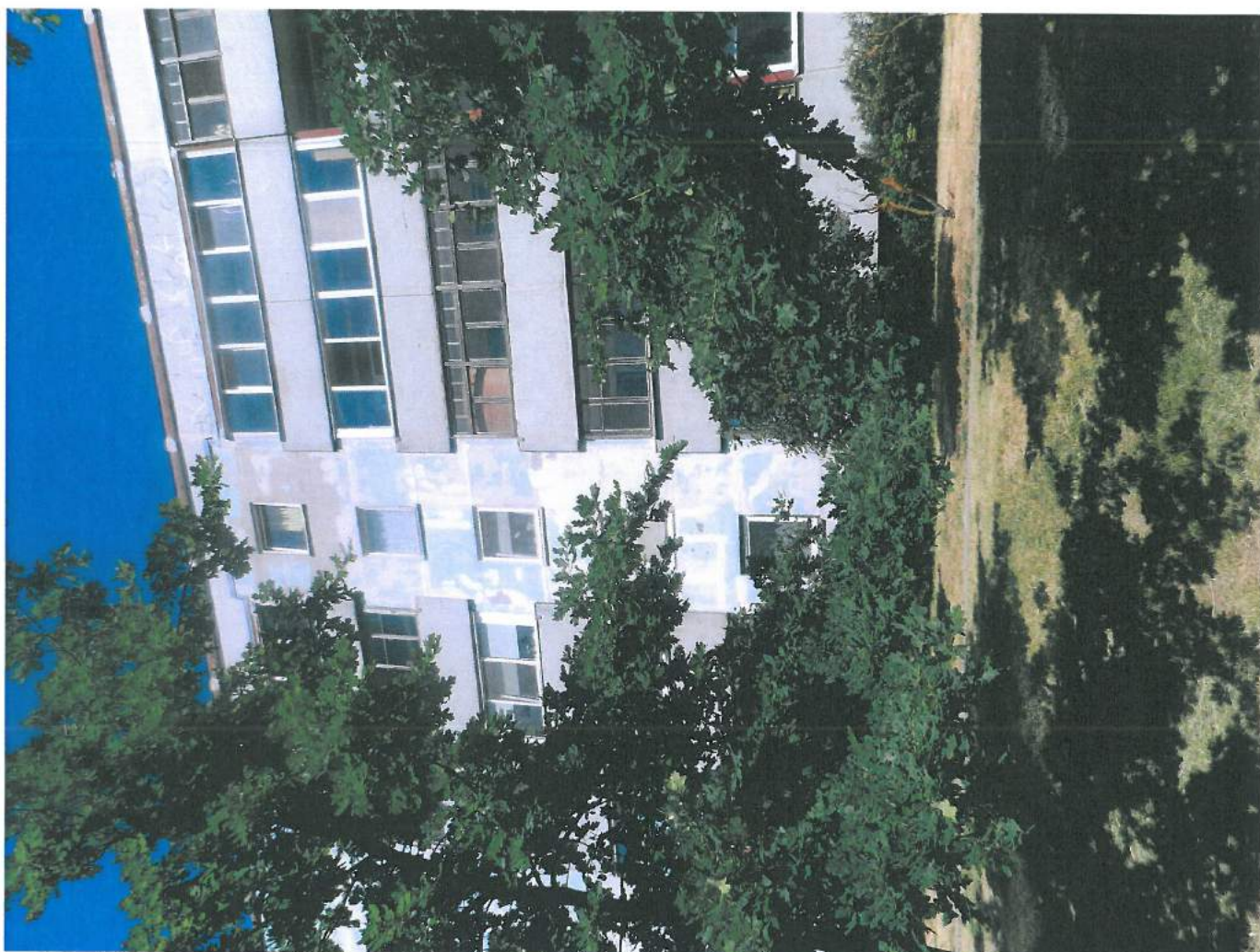
6., 7. att. Ē kas D puses āršienu izvirzītie fragmenti ir mitruma bojāti; lodžiju stiklojums aizsargā āršienā no mitruma.
