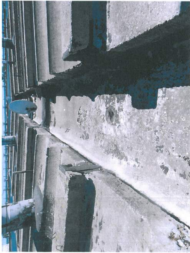
34., 35.att. Jumta tehnēs redzami betona virsmas bojājumi; lielākie defekti nosegti ar ruberoīdu. Jumtam jāveic augšējās virsmas remonts, hidroizolācijas atjaunošana.
