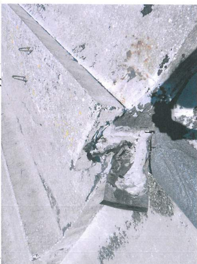
34., 35.att. Jumta tehnēs redzami betona virsmas bojājumi; lielākie defekti nosegti ar ruberoīdu. Jumtam jāveic augšējās virsmas remonts, hidroizolācijas atjaunošana.
