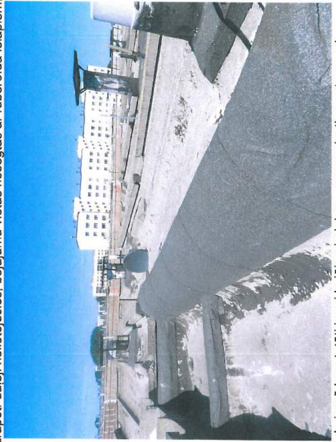
32.,33.att. Jumta elementu bojājumu apmēru jāprecizē pēc ruberoīda noņemšanas; apsekojumā konstatēti jauni bojājumi-plaisas, caurumi, stiegu atsegumi.
