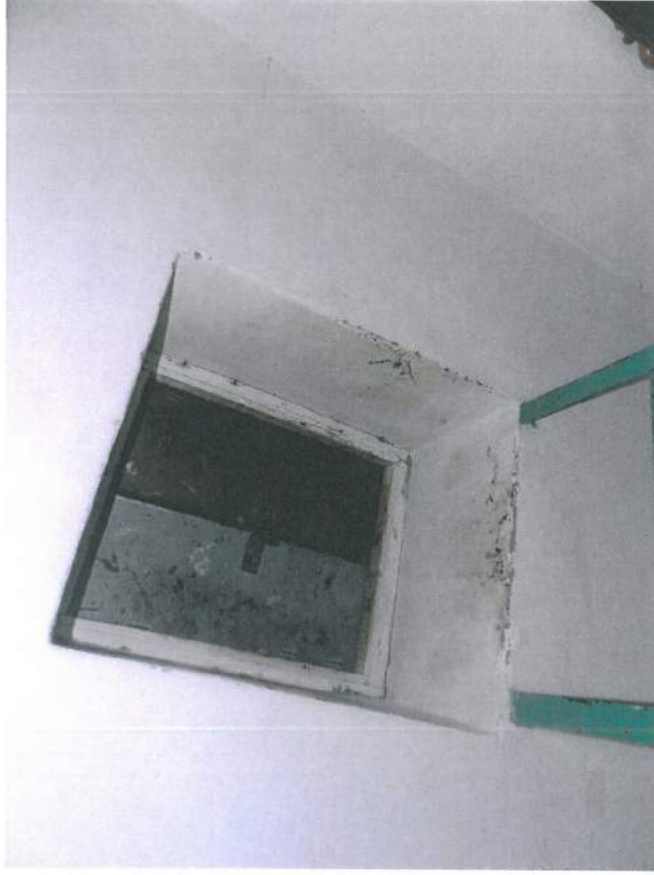
16., 17., 18. att. Ieejas bēniņos ierīkotas no visām kāpņu telpām caur lūku pārsegumā. Lūku vāki jānomaina uz ugunsdrošiem.
