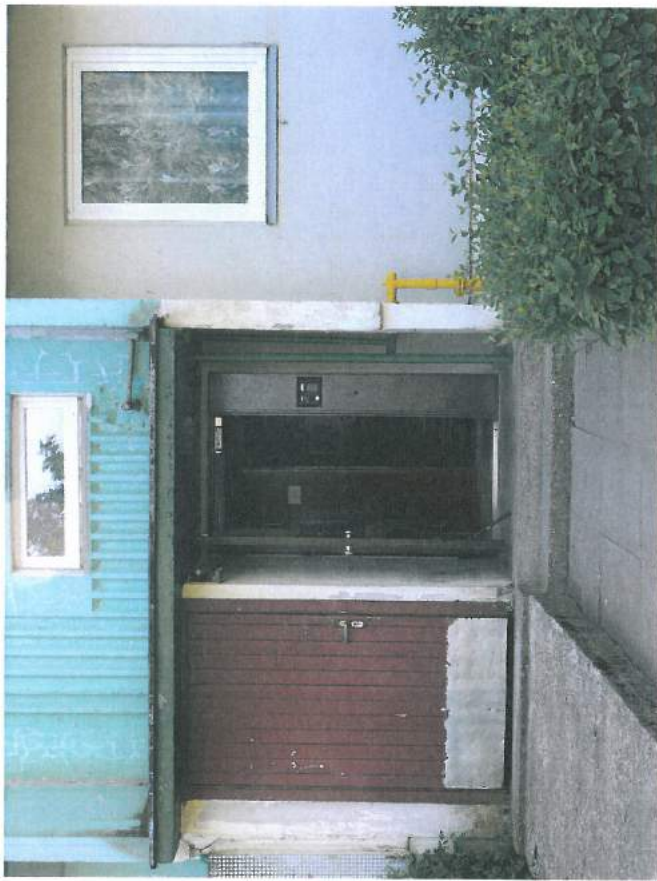
8., 9. att. Dzīvojamās mājas ārējo ieeju mezglu detaļas jāatjauno; ārdurvis ir nomainītas; 4. sekcijas jumtiņu vēlams pagarināt.
