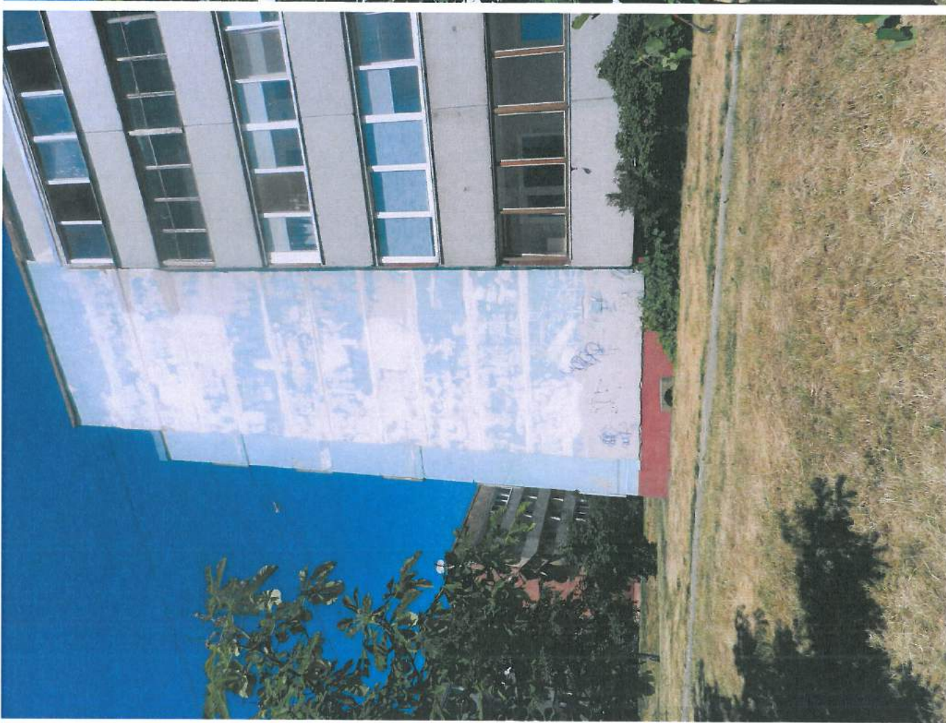
6., 7. att. Ē kas D puses āršienu izvirzītie fragmenti ir mitruma bojāti; lodžiju stiklojums aizsargā āršienā no mitruma.
