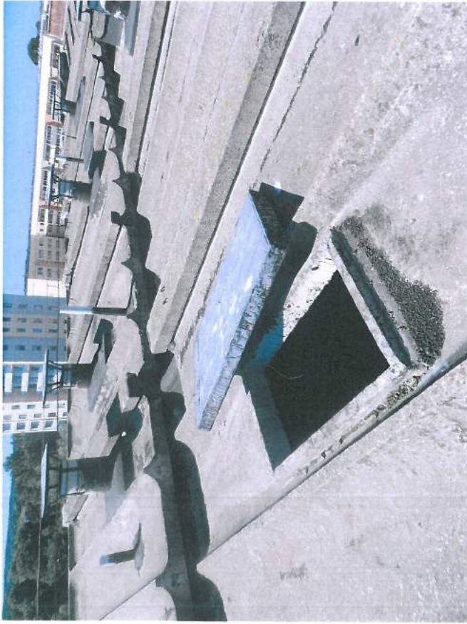
30.,31.att. Dzelzsbetona jumta kopskats; visi jumta elementi-paneli, jumtiņi, margas, parapeti-dalēji nolietojušies; bojājumu vietas nosegtas ar ruberoīda ielāpiem.
