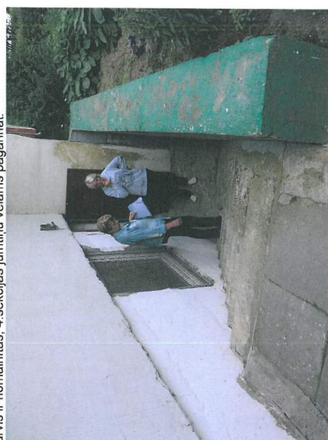
10., 11. att. Betona apmale ierīkota tikai pie izvirzītajām ārsienām. Pagraba ieejām jānomaina ārdurvis; jāatjauno pakāpienu un atbalstsienu virsma.
