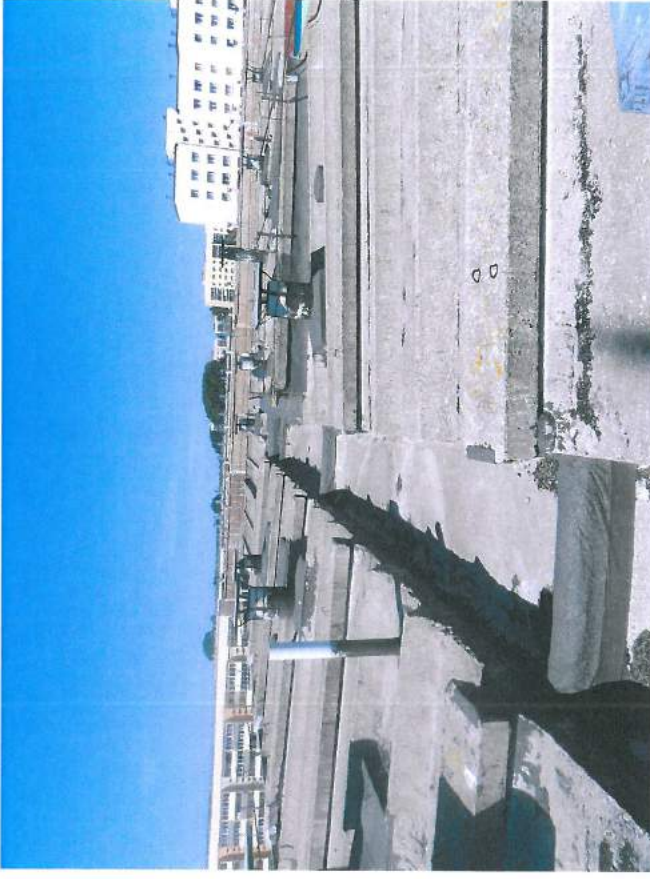
30.,31.att. Dzelzsbetona jumta kopskats; visi jumta elementi-paneli, jumtiņi, margas, parapeti-dalēji nolietojušies; bojājumu vietas nosegtas ar ruberoīda ielāpiem.
