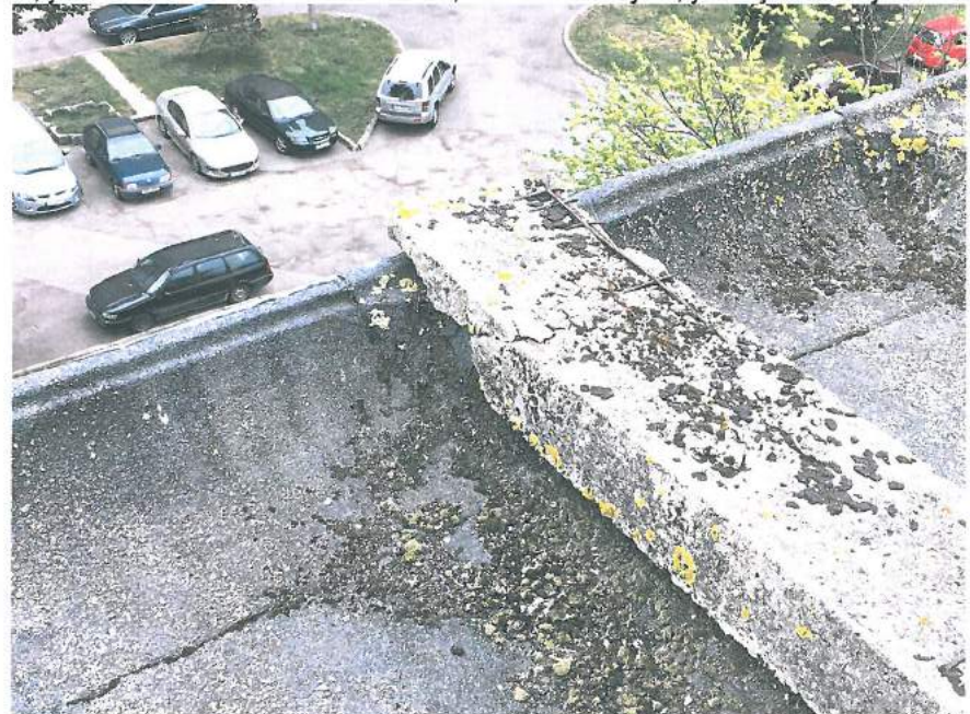
18., 19. att. Jumta elementi tuvplānā: betona „cepures” nolietojušās; ruberoīds apsūņojis, piegruzots; jumts pilnībā neveic savu funkciju-aizsardzību pret ārējiem nokrišņiem.
