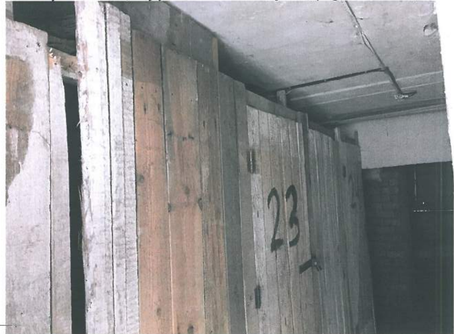
10.,11.att. Pirms pārseguma siltināšanas jāpārliet pie griestiem izvilktie kabeļi; 6 palikušiem koka šķūnīšiem jānozāgē sienu augša par 20 cm ; sienas jānostiprina..
