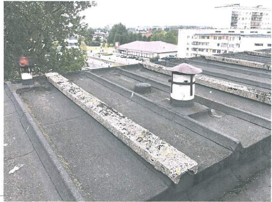
16., 17. att. Dzelzsbetona paneļu jumta kopskats: nav margu; „cepures” sliktā stāvoklī; jumta virsma klāta ar ruberoīdu, kas ir nolietojies; jumtiņi sarūsējuši.
