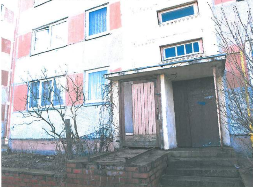
6.,7.att. Ārējā ieeja pagalma pusē. Pakāpieni daļēji nevienādi, lieveņi un ārdurvis nolietojušās; jumtīņa virsma bojāta; konteineru laukums netiek izmantots.
