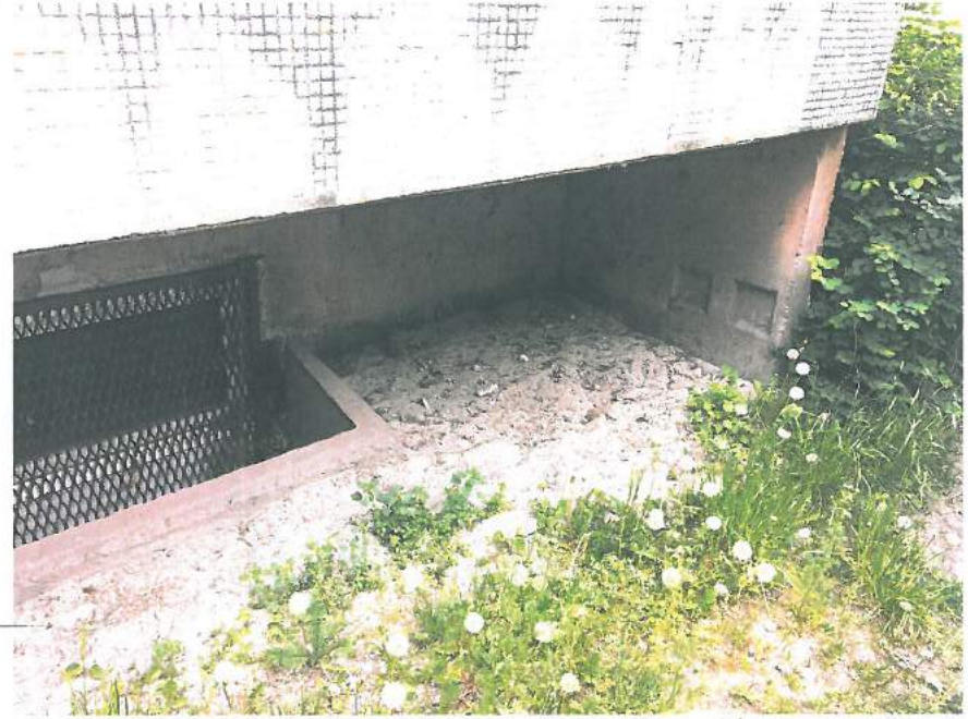
4.,5.att. Galvenā ārējā ieeja. Pakāpieni nevienādi, nolietojušies; slīpne sabrukusi, lieveņi un ārdurvis nolietojušās. Gaismas šaftas bez režģa un apmales.
