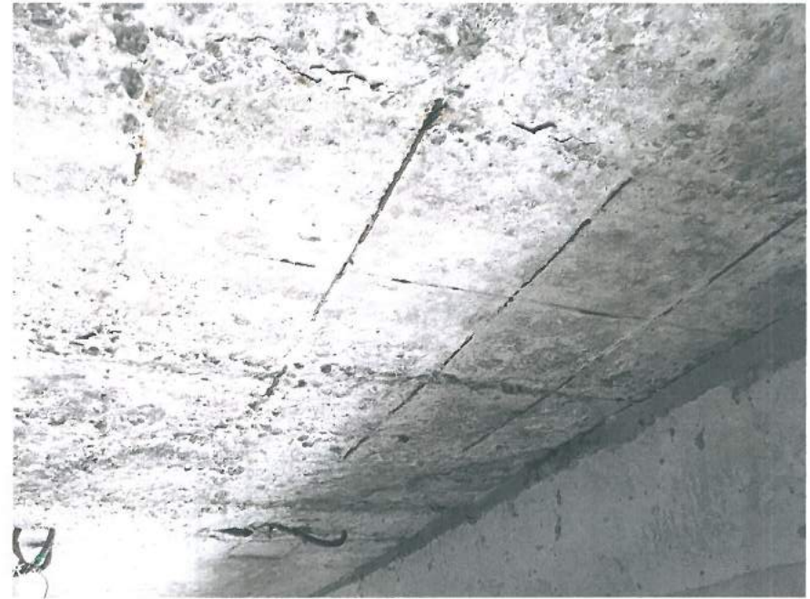
12.,13.att. Bēniņu pārsegums jāsilcina. Jumta paneļu un tekņu virsma bojāta: konstatētas plaisas, stiegru atsegumi, melna virsma kondensāta mitruma iespaidā.
