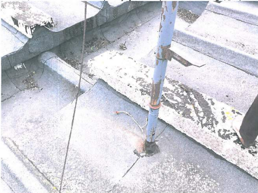
18., 19. att. Jumta elementi tuvplānā: betona „cepures” nolietojušās; ruberoīds apsūņojis, piegruzots; jumts pilnībā neveic savu funkciju-aizsardzību pret ārējiem nokrišņiem.
