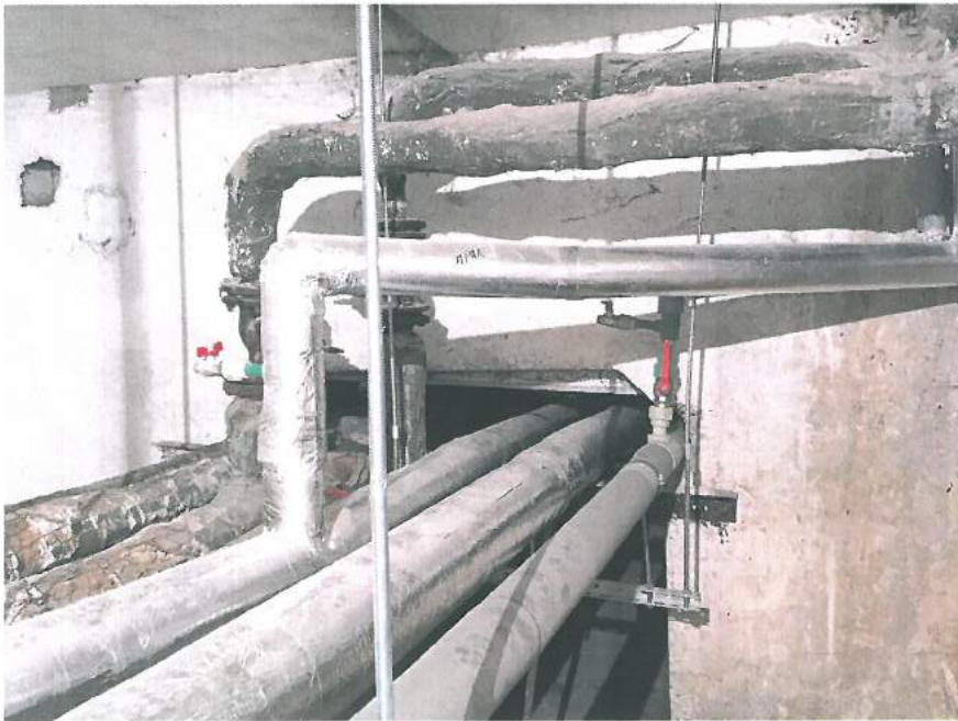
8.,9.att. Ēkas pagrabā nomainītas aukstā un karstā ūdens apgādes, kā arī sadzīves kanalizācijas caurules; daļēji demontēti koka šķūnīši; pagrabas sauss, tīrs.
