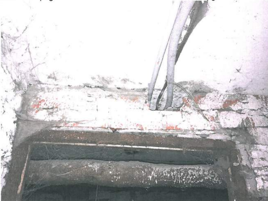
10.,11.att. Pirms pārseguma siltināšanas jāpārliet pie griestiem izvilktie kabeli; nomainītas aukstā un karstā ūdens apgādes, kā arī sadzīves kanalizācijas caurules.
