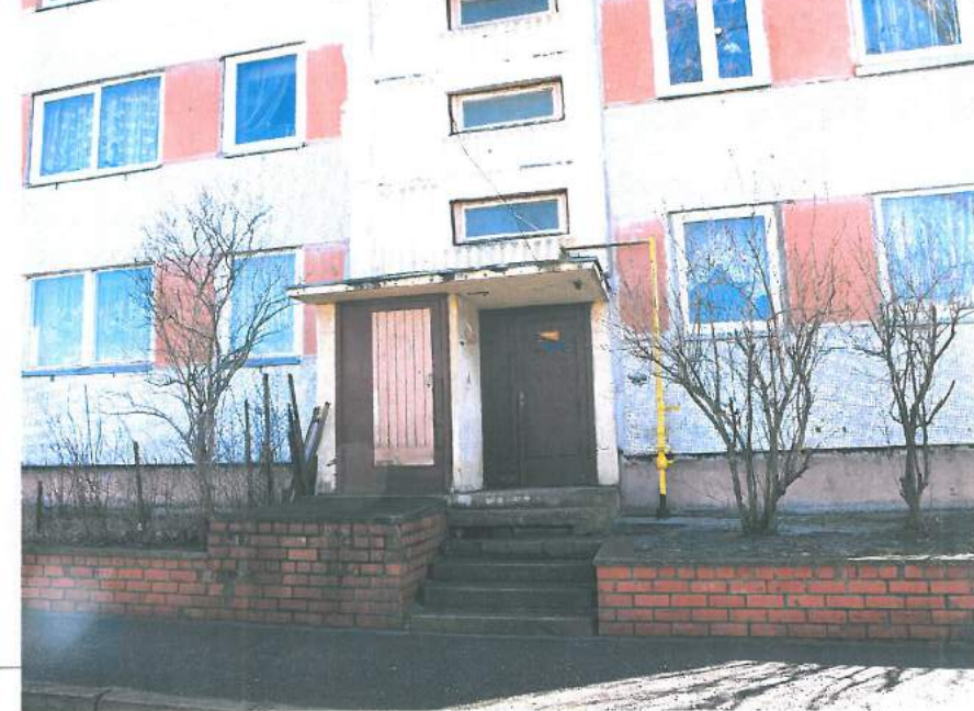
6.,7.att. Ārējā ieeja pagalma pusē. Pakāpieni daļēji nevienādi, lieveņi un ārdurvis nolietojušās; jumtīņa virsma bojāta; konteineru laukums netiek izmantots.
