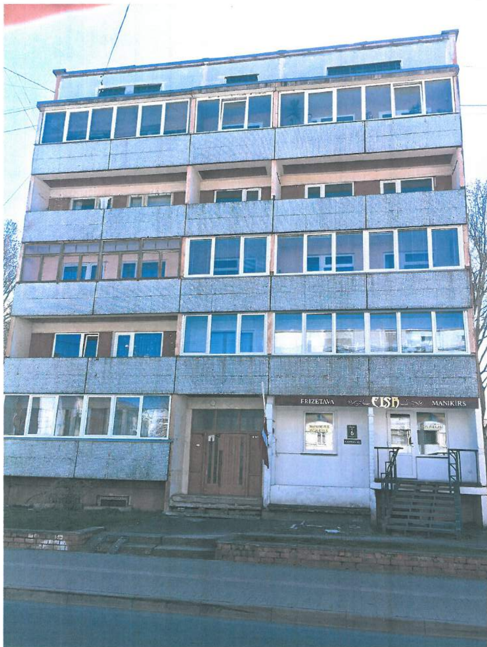
2.,3.att. Dzīvojamā ēka, kad.apz.17000440113001, M.Ķempes ielā 6, Liepājā; ielas puses un pagalma puses fasāde, kuras apdare cietusi no ārējās atmosfēras iedarbības.
