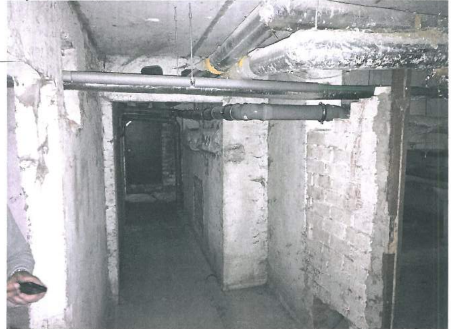
10.,11.att. Pirms pārseguma siltināšanas jāpārliet pie griestiem izvilktie kabeli; nomainītas aukstā un karstā ūdens apgādes, kā arī sadzīves kanalizācijas caurules.
