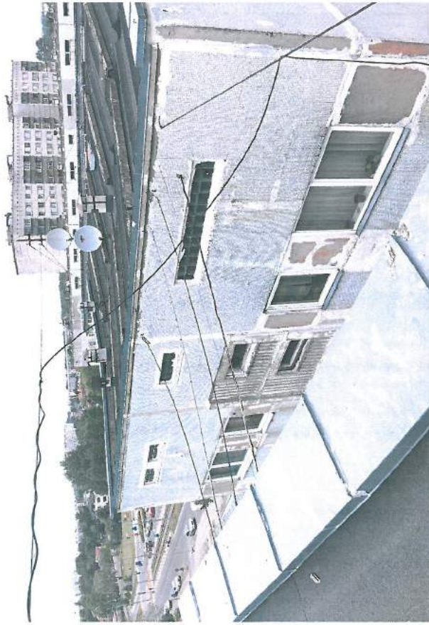
16., 17. att. Dzelzsbetona paneļu jumta kopskats: nav margu; „cepures” sliktā stāvoklī; jumta virsma klāta ar ruberoīdu, kas ir nolietojies; āršienā šķērso daudzi kabeli.
