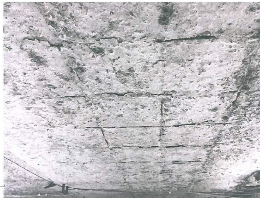
12.,13.att. Bēniņu pārsegums jāsiltina. Jumta paneļu un tekņu virsma bojāta: konstatētas plaisas, stiegru atsegumi, melna virsma kondensāta mitruma iespaidā.
