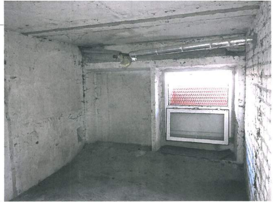
8.,9.att. Ēkas pagrabā nomainītas aukstā un karstā ūdens apgādes, kā arī sadzīves kanalizācijas caurules; demontēti visi koka šķūnīši; pagraba telpas ir sausas, tīras.
