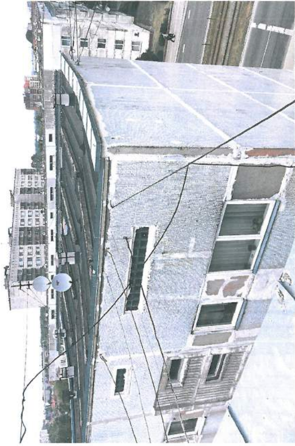
16., 17. att. Dzelzsbetona paneļu jumta kopskats: nav margu; „cepures” sliktā stāvoklī; jumta virsma klāta ar ruberoīdu, kas ir nolietojies; āršienā šķērso daudzi kabeli.
