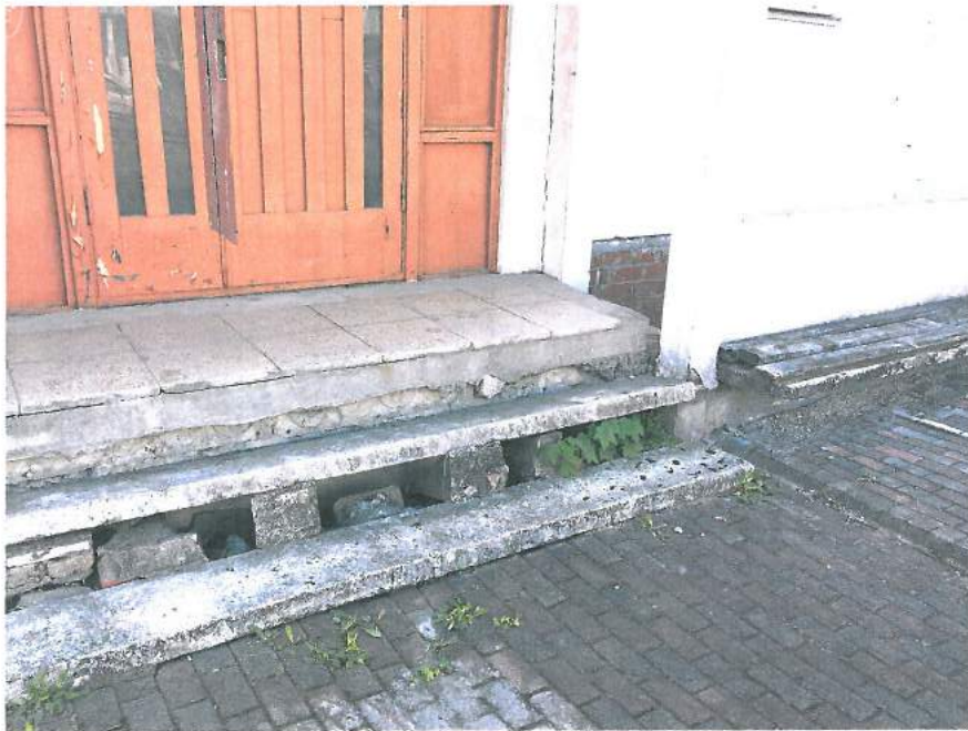
4.,5.att. Ārējā ieeja ielas pusē. Pakāpieni daļēji sabrukuši, betona lieveņi un ārdurvis nolietojušās. Redzami nepabeigti dobumu un šuvju aizpildījumi.
