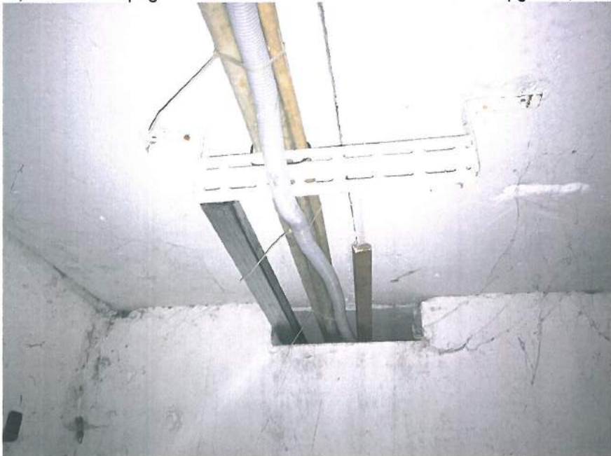
10.,11.att. Pirms pārseguma siltināšanas jāpārliet pie griestiem izvilktie kabeļi; 6 palikušiem koka šķūnīšiem jānozāgē sienu augša par 20 cm ; sienas jānostiprina..
