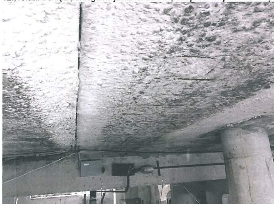
14.,15.att. Dažiem jumta paneļiem ir plaisas, atsegts stiegrojums, mitri plankumi, betona izskalojumi. Pa perimetru ir tukšas šuves; daļēji aizpildītas ar putām
