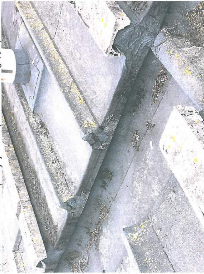
18., 19. att. Jumta elementi tuvplānā: betona „cepures” nolietojušās; ruberoīds apsūņojis, piegrūzots; jumts pilnībā neveic savu funkciju-aizsardzību pret ārējiem nokrišņiem.
