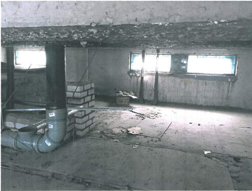
12.,13.att. Bēniņu pārsegums jāsilcina. Jumta paneļu un tekņu virsma bojāta: konstatētas plaisas, stiegru atsegumi, melna virsma kondensāta mitruma iespaidā.
