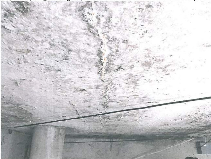
14.,15.att. Dažiem jumta paneļiem ir plaisas, atsegts stiegrojums, mitri plankumi, betona izskalojumi. Pa perimetru ir tukšas šuves; daļēji aizpildītas ar putām
