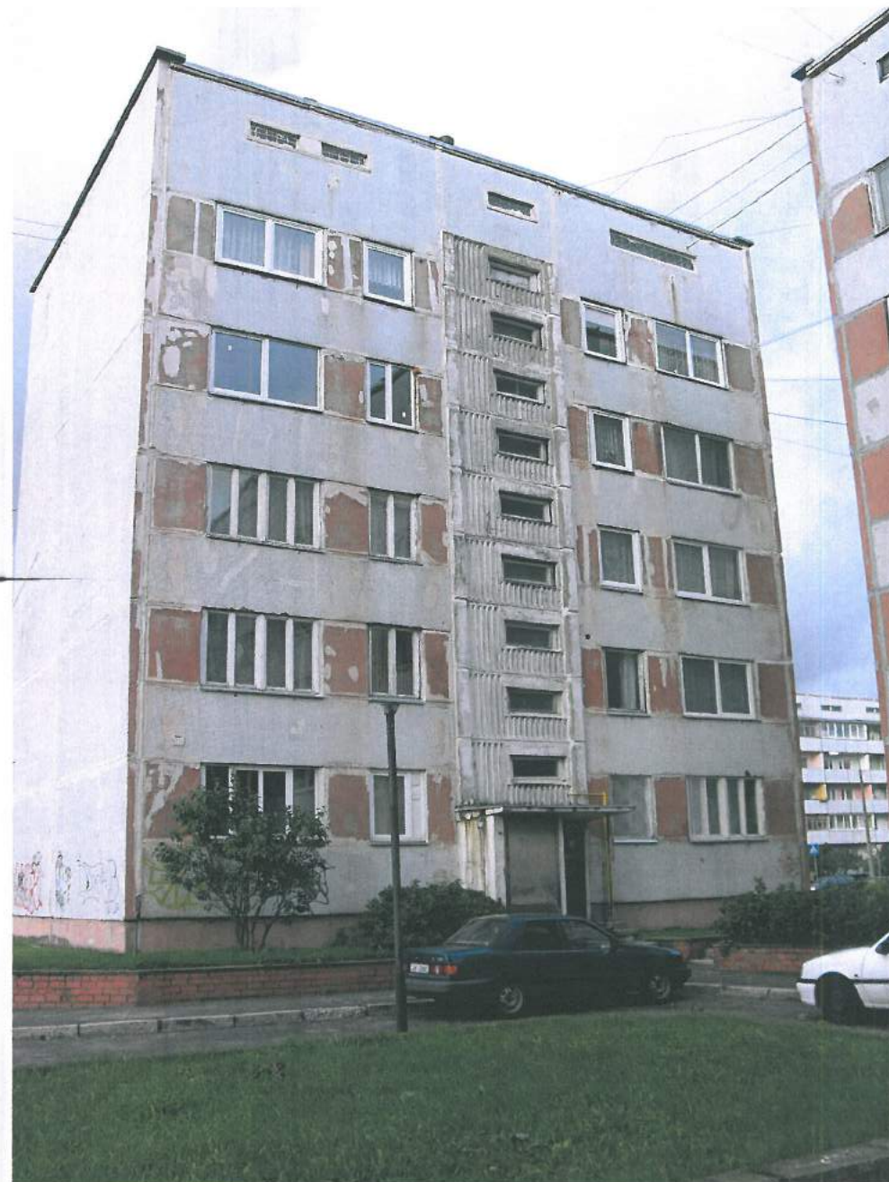
2.,3.att. Dzīvojamā ēka, kad.apz.17000440113001, M.Ķempes ielā 6, Liepājā; ielas puses un pagalma puses fasāde, kuras apdare cietusi no ārējās atmosfēras iedarbības.
