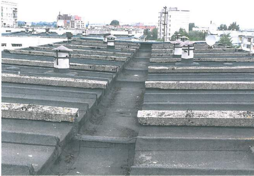
16., 17. att. Dzelzsbetona paneļu jumta kopskats: nav margu; „cepures” sliktā stāvoklī; jumta virsma klāta ar ruberoīdu, kas ir nolietojies; jumtiņi sarūsējuši.
