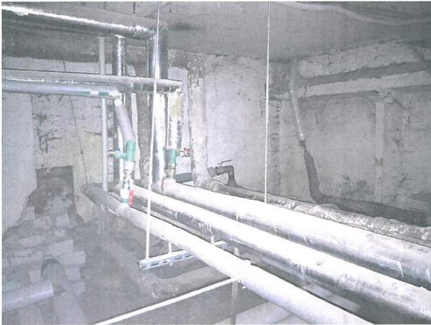
8.,9.att. Ēkas pagrabā nomainītas aukstā un karstā ūdens apgādes, kā arī sadzīves kanalizācijas caurules; demontēti visi koka šķūnīši; pagraba telpas ir sausas, tīras.
