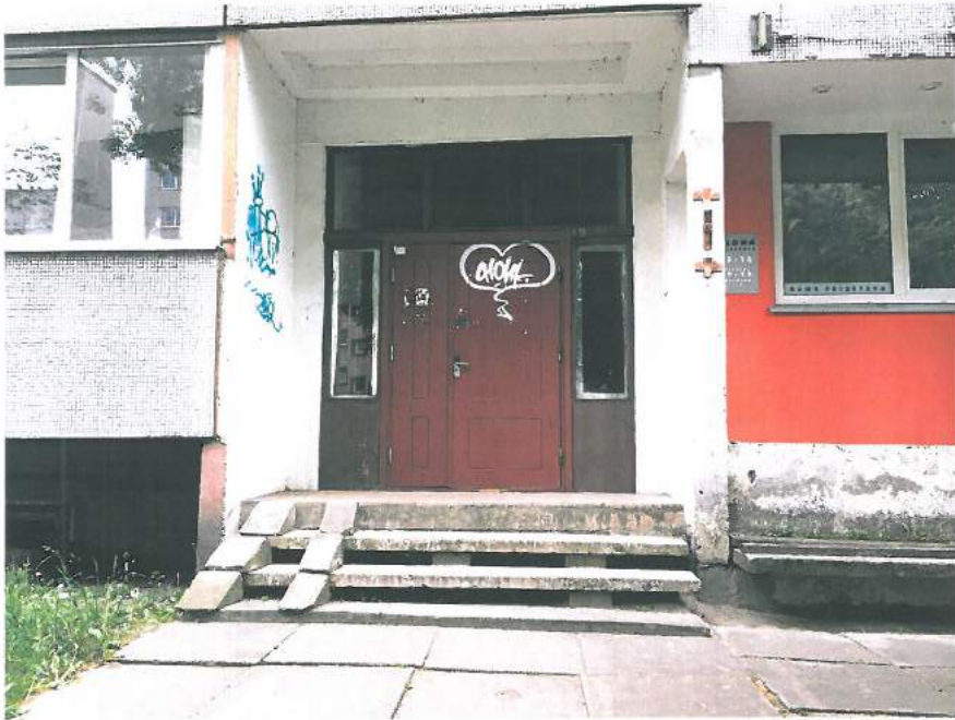
4.,5.att. Galvenā ārējā ieeja. Pakāpieni nevienādi, nolietojušies; slīpne sabrukusi, lieveņi un ārdurvis nolietojušās. Gaismas šaftas bez režģa un apmales.
