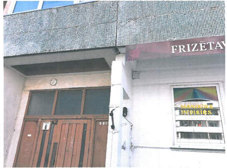
4.,5.att. Ārējā ieeja ielas pusē. Pakāpieni daļēji sabrukuši, betona lieveņi un ārdurvis nolietojušās. Redzami nepabeigti dobumu un šuvju aizpildījumi.
