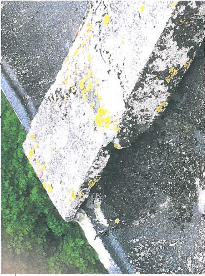
18., 19. att. Jumta elementi tuvplānā: betona „cepures” nolietojušās; ruberoīds apsūņojis, piegrūzots; jumts pilnībā neveic savu funkciju-aizsardzību pret ārējiem nokrišņiem.
