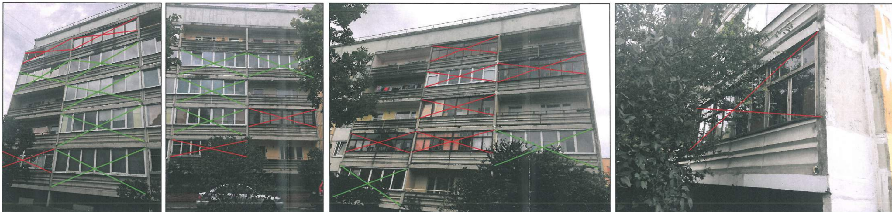
Demontējamo lodžiju iestiklojumu norādes ēkas fasādē asīs A-I (demontējami 8gb. lodžiju stiklojumi)
