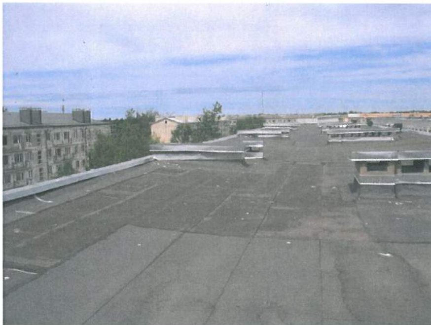
Ventilācijas izvadi remontēti un to nosedzošie jumtiņi savesti kārtībā.
