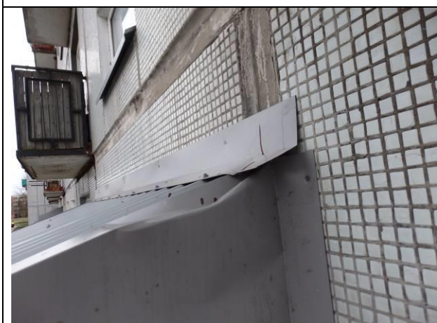
11. Austrumu fasādes fragments, ieejas jumtiņu pieslēgums
