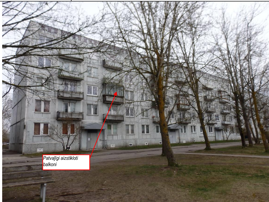
16. Rietumu fasādes kopskats
