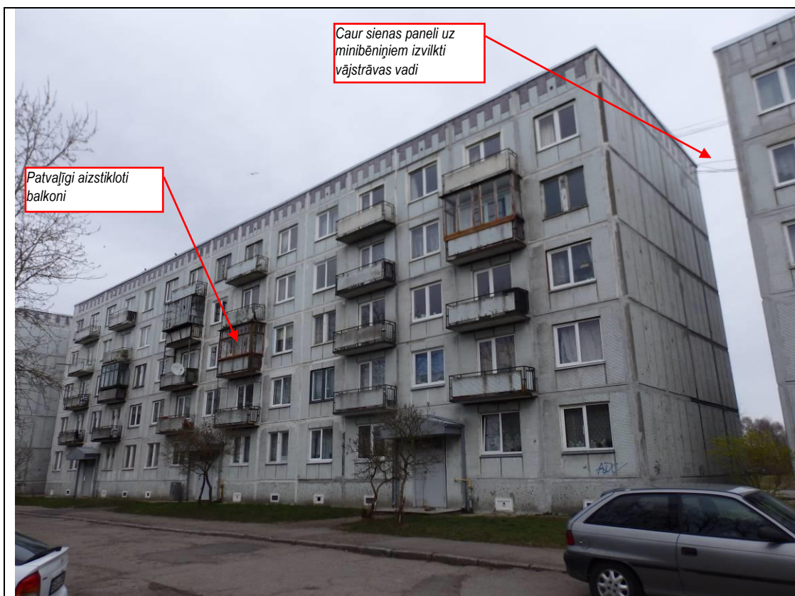
15. Rietumu fasādes kopskats
