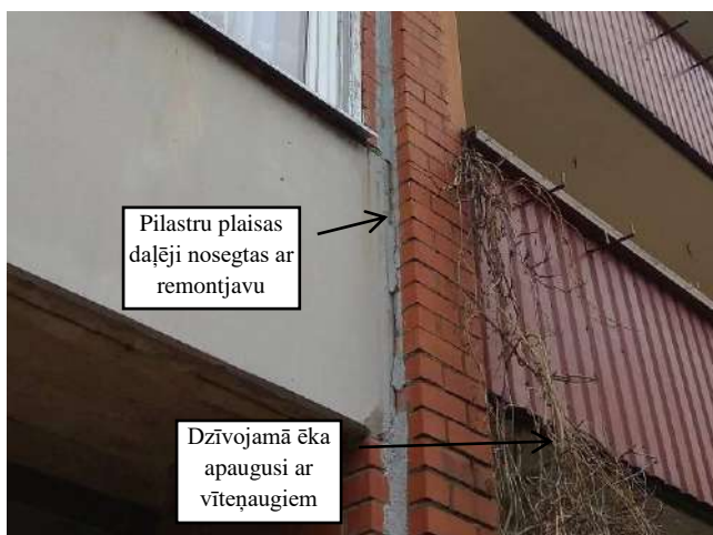
Ēkas sienas 23. Dienvidu fasādes fragments
