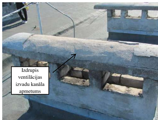
Ventilācijas izvadu kanāls 50. Jumts
