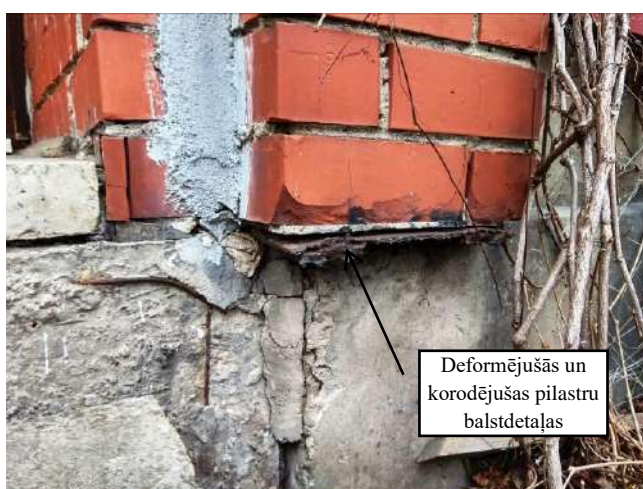
Pilastra balst detaļas 22. Dienvidu fasādes fragments
