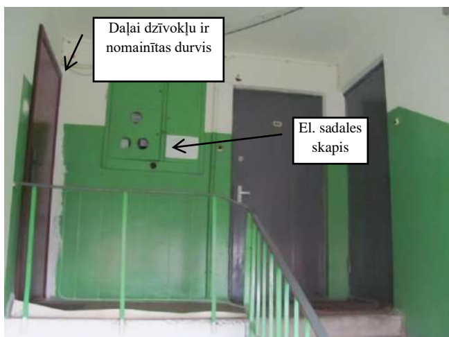
Kāpņu telpas sienas 57. Kāpņu telpa, dzīvoklis
