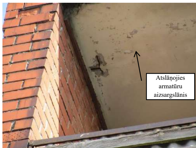
Lodžijas pārsegums 30. Dienvidu fasādes fragments
