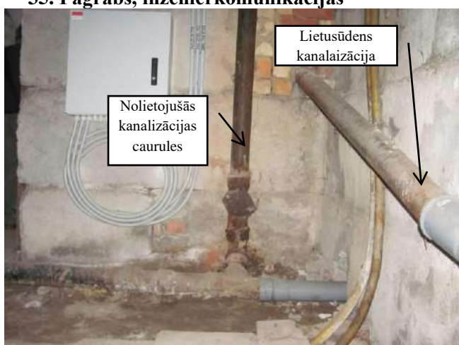
Kanalizācijas stāvvads 37. Pagrabs, inženierkomunikācijas
