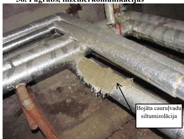
Maģistrālo cauruļvadu siltumizolācija 38. Pagrabs, inženierkomunikācijas
