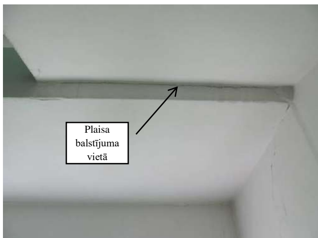
Kāpņu balstījuma vieta 61. Kāpņu telpa
