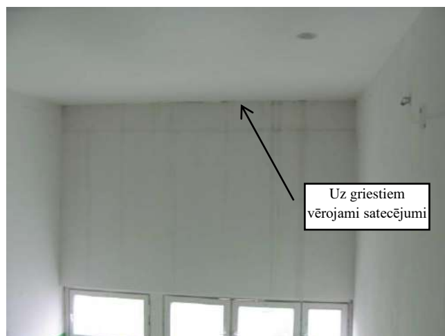
Piektā stāva kāpņu telpa 58. Kāpņu telpa
