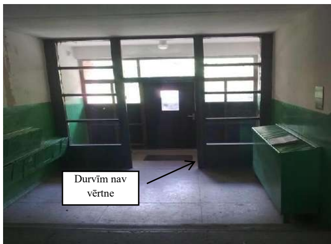
Ieeja kāpņu telpā no ielas puses 55. Kāpņu telpa
