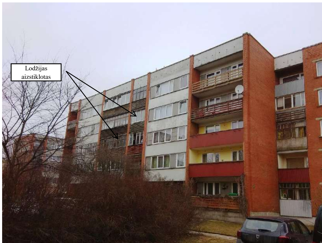
16. Dienvidu un Austrumu fasādes fragments
