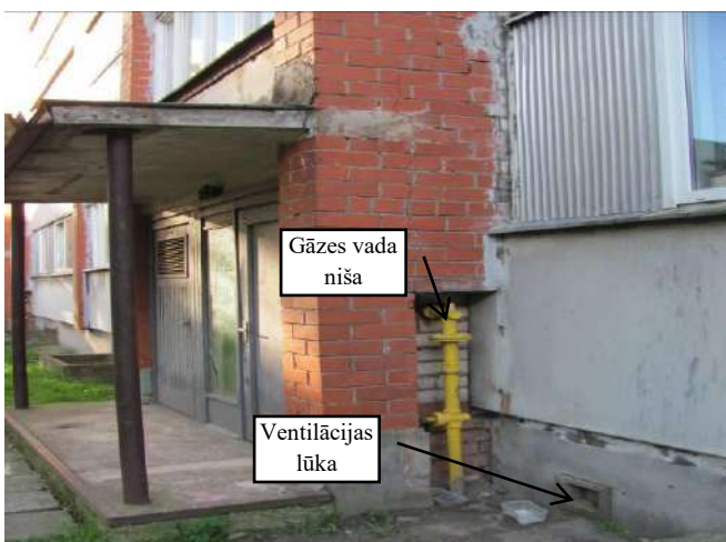
Fasādes fragments 11. Ziemeļu fasādes fragments
