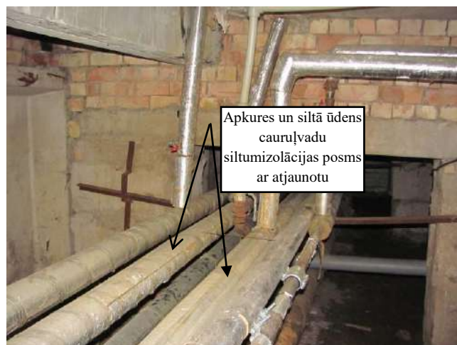
Apkures un siltā ūdens cauruļvadu siltumizolācijas posms ar atjaunotu 36. Pagrabs, inženierkomunikācijas
