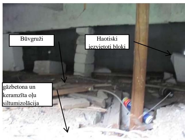
Esošais siltinājums 46. Bēniņi
