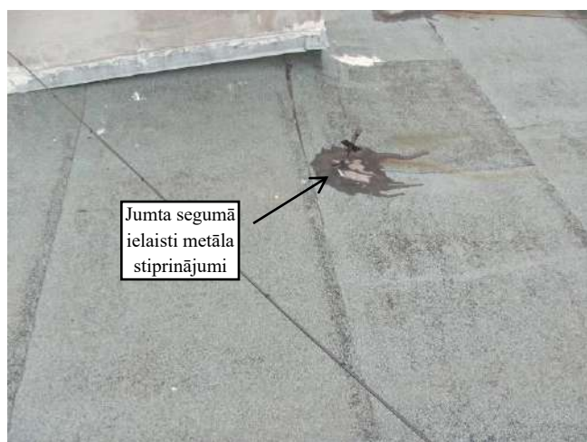
Jumta segums 54. Jumts
