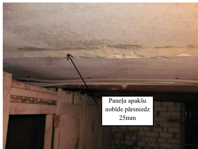
Dobtie pārseguma paneļi 44. Pagrabs
