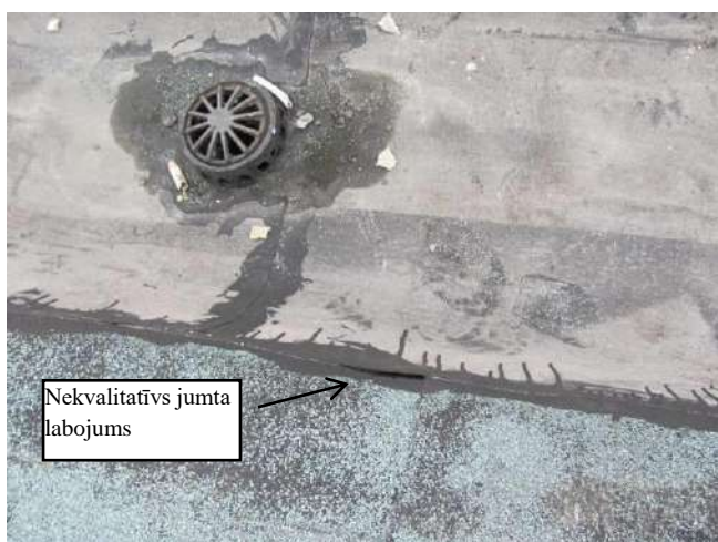
Jumta segums 53. Jumts
