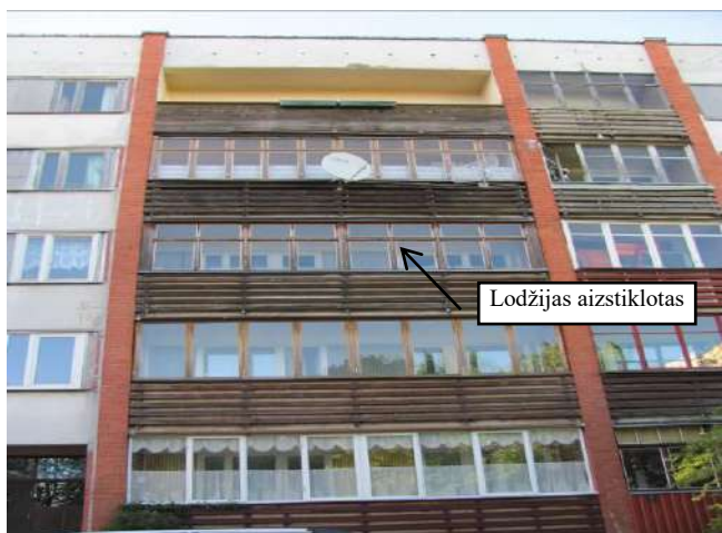
Dzīvojamās ēkas lodžijas 29. Dienvidu fasādes fragments
