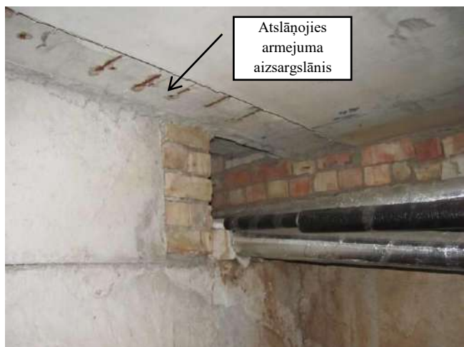
Pārseguma panelis 41. Pagrabs, inženierkomunikācijas
