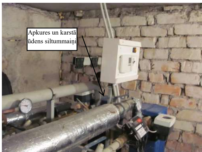
Siltummezgls ar neatkarīgo pieslēguma shēmu 33. Pagrabs, inženierkomunikācijas
