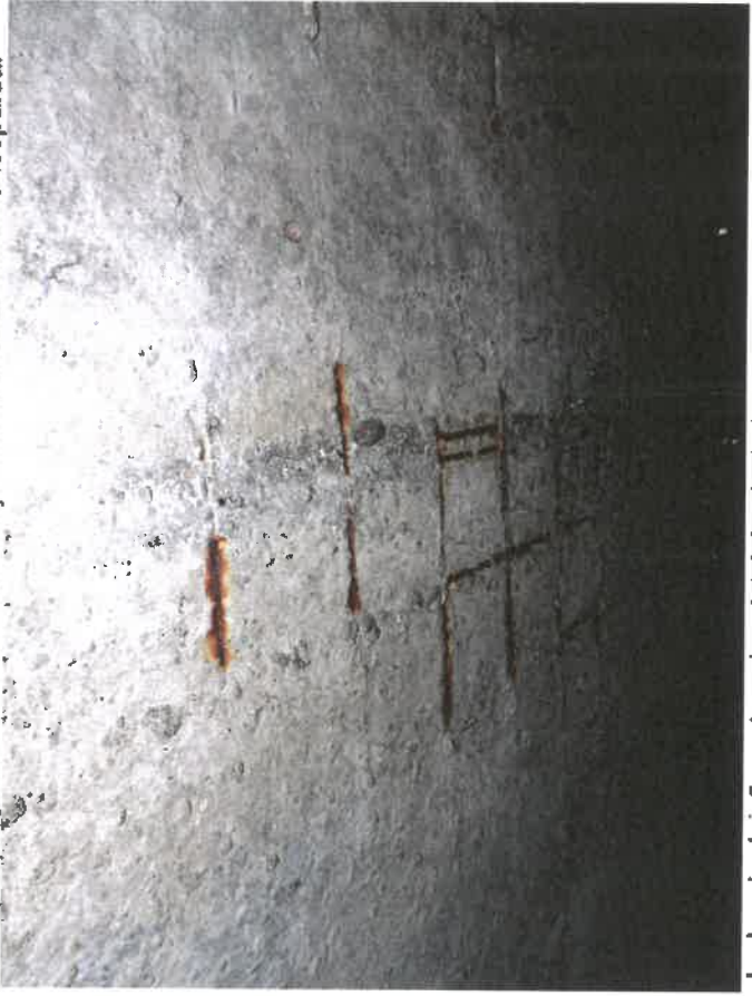
24., 25.att. Bēniņu pārsegums jāsilītina. Jumta paneļos un teknēs konstatētas plaisas, stiegru atsegumi, virsma ir nolieņējusi kondensāta mitruma iespaidā.
