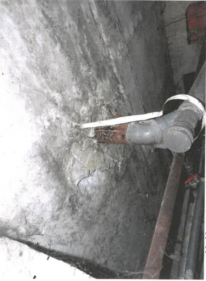
20.,21.att. Pagraba pārsegums jāsitina no apakšas; skūnīši ir nojaukti; pagraba logi aizpildīti ar metāla plātnēm; nav pietiekamas gaisa apmaiņas.
