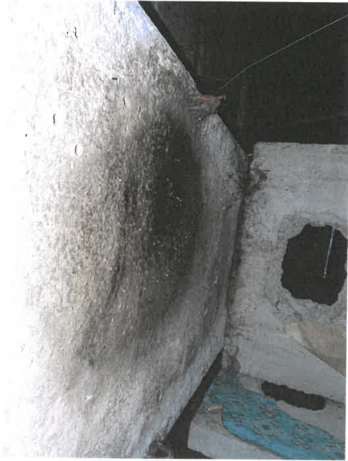
28.,29att. Vairākās tehnēs ir sānu plaisas, izskalījumi, nomainējums kondensāta ietekmē. Nokrišņu ūdens notekas mainītas.
