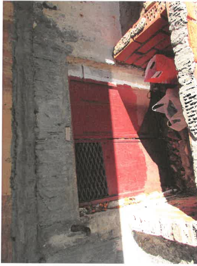
17.att. Gaismas šahtas pie pagraba logiem piegružotas; mūra sienīņas mitruma bojātas.
