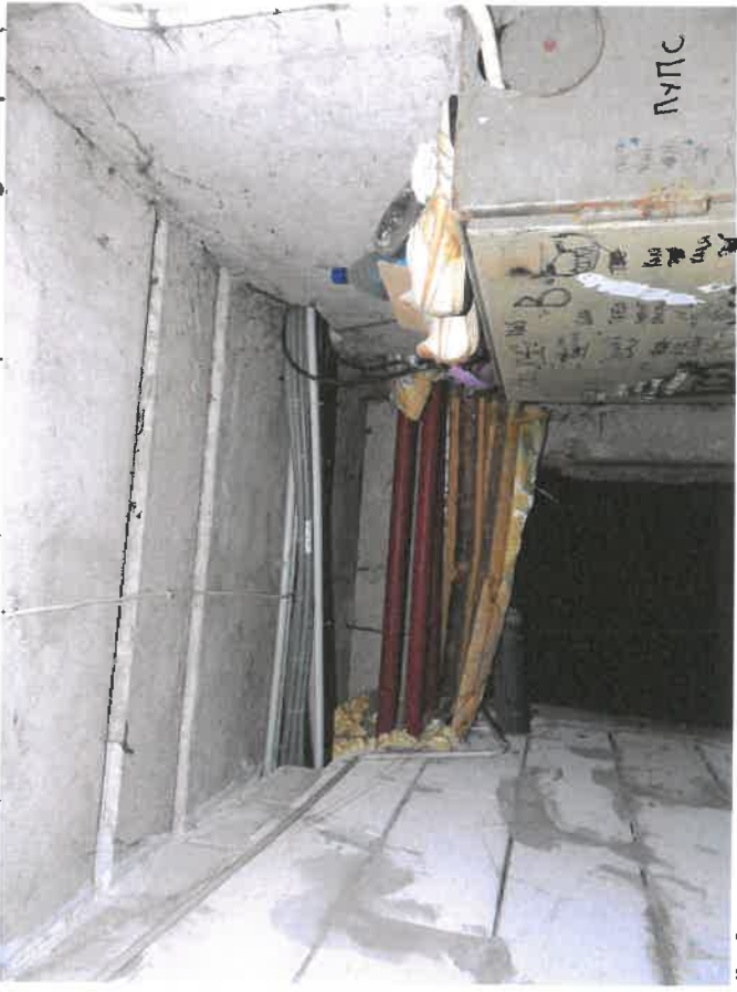
20.,21.att. Pagraba pārsegums jāsitina no apakšas; skūnīši ir nojaukti; pagraba logi aizpildīti ar metāla plātnēm; nav pietiekamas gaisa apmaiņas.
