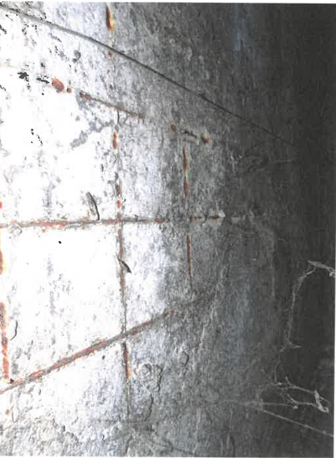
24., 25.att. Bēniņu pārsegums jāsilītina. Jumta paneļos un teknēs konstatētas plaisas, stiegru atsegumi, virsma ir nolieņējusi kondensāta mitruma iespaidā.
