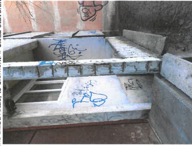
7.att. Pagalma puses ieejas netiek izmantotas un tiks aizbūvētas; to elementi ir sliktā stāvoklī.
