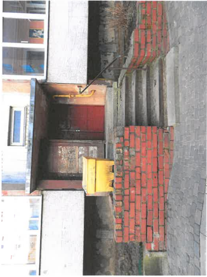
6.att. Galveno ieeju jumtiņi, lieveņi, kāpnes un ārdurvis nolietotojūšs.
