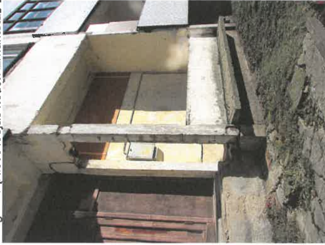
7.att. Pagalma puses ieejas netiek izmantotas un tiks aizbūvētas; to elementi ir sliktā stāvoklī.
