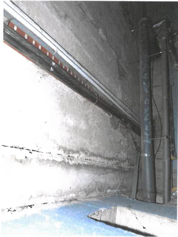
20.,21.att. Pagraba pārsegums jāsitina no apakšas; skūnīši ir nojaukti; pagraba logi aizpildīti ar metāla plātnēm; nav pietiekamas gaisa apmaiņas.
