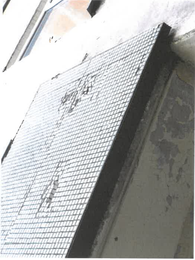
16.att. Lodžiju margu un paneļu virsma bojāta.
