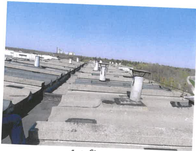
5.att. Ēkas jumts
