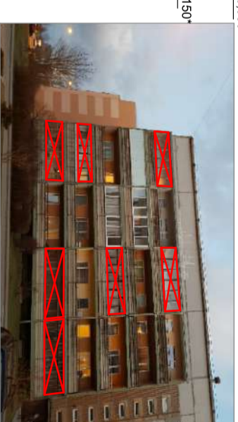
Likvidējamie lodžiju aizstiklojumi (kopā 7 gab logu bloki 6.3x1.55m*)
