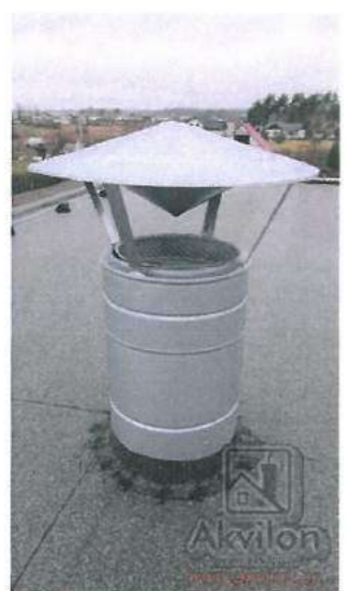
ventilācijas izvada jumtiņš ar sietu, analoga SIA AKVILON ražot.
