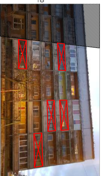
Likvidējamie lodžiju aizstiklojumi (kopā 5 gab konstr. 6.3x1.55m*)
