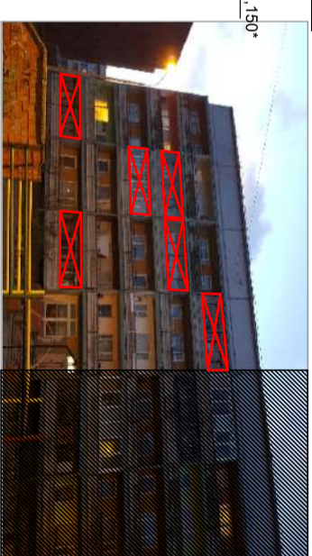
Likvidējamie lodžiju aizstiklojumi (kopā 6 gab logu bloki 6.3x1.55m)
