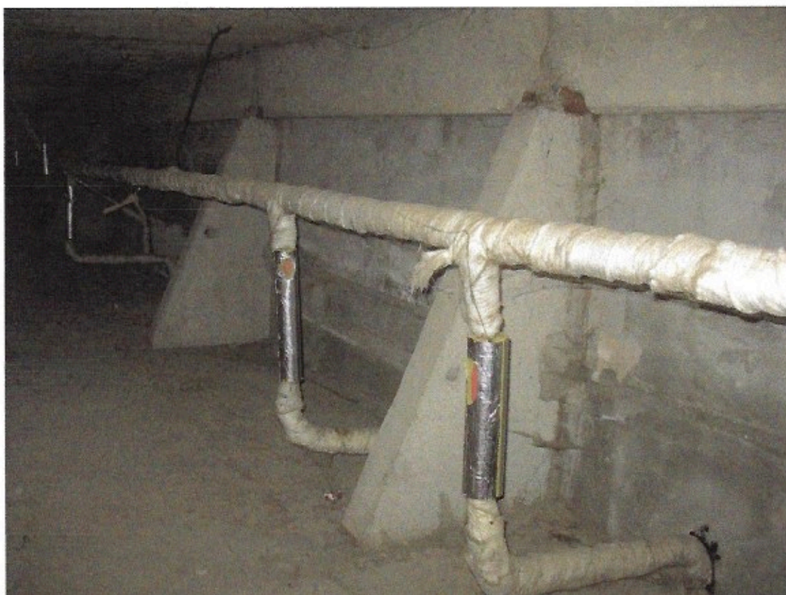
5. fotoattēls. Jumta konstrukcijas siju balstījums bēniņos.
