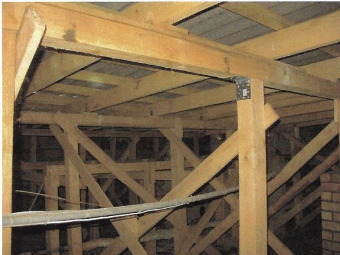
10. fotoattēls. Koka konstrukcijas jumts ar viļņoto lokšņu segumu.
