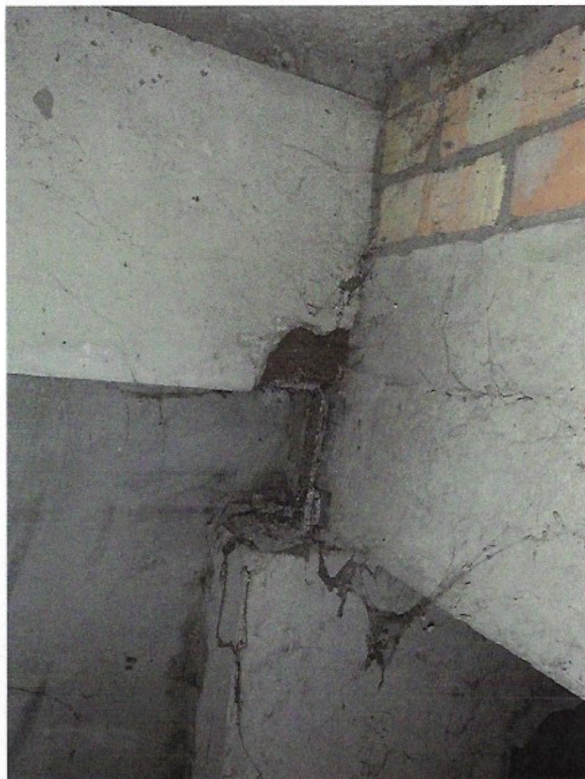
12. fotoattēls. Nedrošs sijas balstījums.
