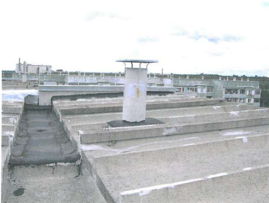
23., 24.att. Dzelzsbetona paneļu jumta kopskats; nav margu; jumtiņu un betona paneļu virsma nolietojusies, vietām saplaisājusi, izdrupusi. Teknēs u.c. ieklāts ruberoīds.
