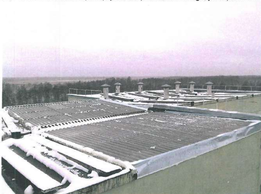
25., 26.att. Jumta paneļi dažās zonās demontēti kritiskā tehniskā stāvokļa dēļ – te ierīkots pagaidu jumts, kas balstās uz bēniņos izbūvēta koka karkasa.
