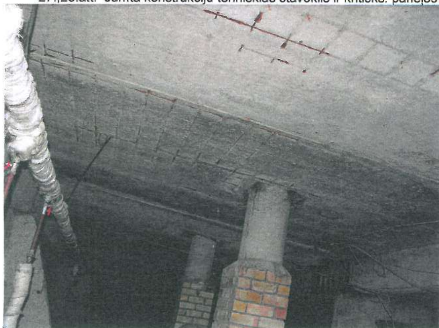
29.,30.att. Daudziem jumta paneļiem ir plaisas, atsegts stiegrojums, mitri plankumi. Teknēs ir plaisas, izskalojumi. Nokrišņu ūdens notekas mainītas.
