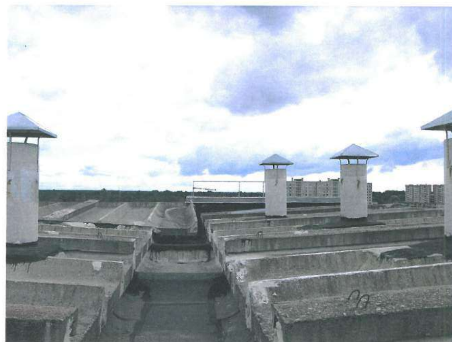
23., 24.att. Dzelzsbetona paneļu jumta kopskats; nav margu; jumtiņu un betona paneļu virsma nolietojusies, vietām saplaisājusi, izdrupusi. Teknēs u.c. ieklāts ruberoīds.
