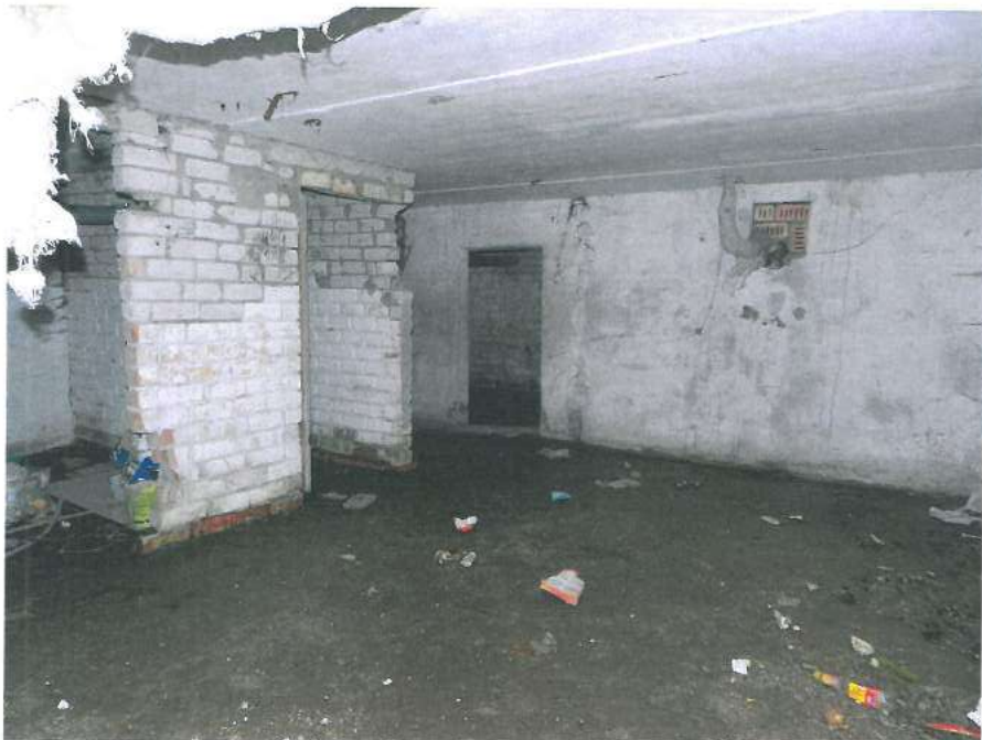
15.,16.att. Veicama pagraba pārseguma siltināšana no apakšas un inženiertīklu nomaiņa. Pagraba logi aizpildīti; grīda pludo – tās ir ūdens ~10 cm dziļi.
