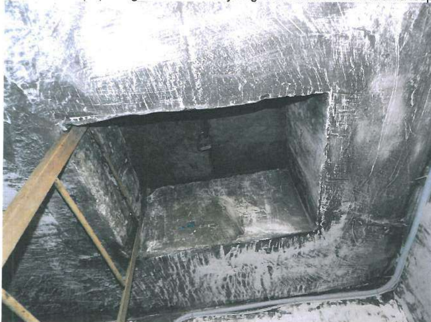
22.,23.att. Lūka uz bēniņiem neatbilst ugunsdrošības prasībām un ir jānomaina. Bēniņu pārsegums jāsilina pēc jauna jumta ierīkošanas.
