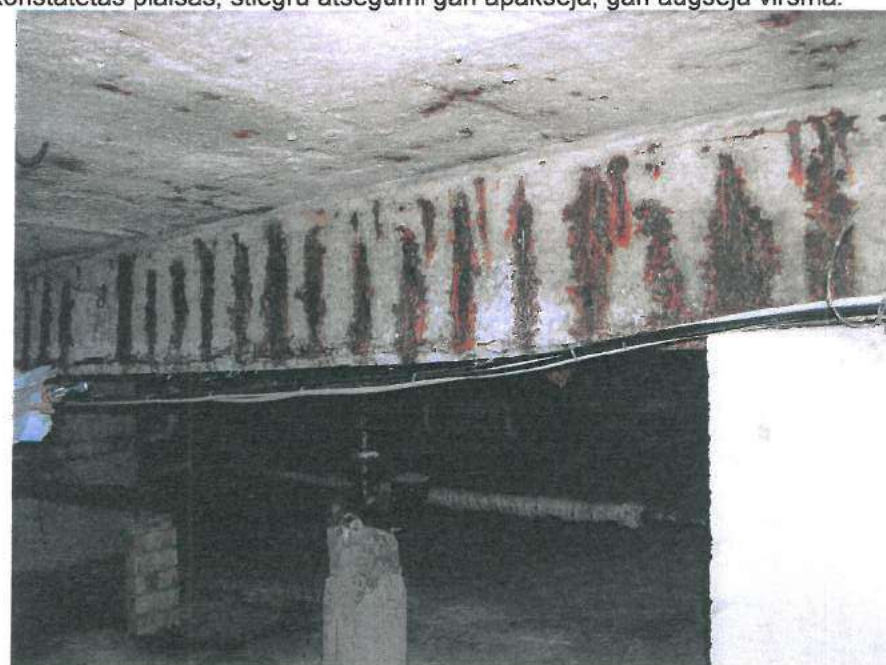
29.,30.att. Daudziem jumta paneļiem ir plaisas, atsegts stiegrojums, mitri plankumi. Teknēs ir plaisas, izskalojumi. Nokrišņu ūdens notekas mainītas.
