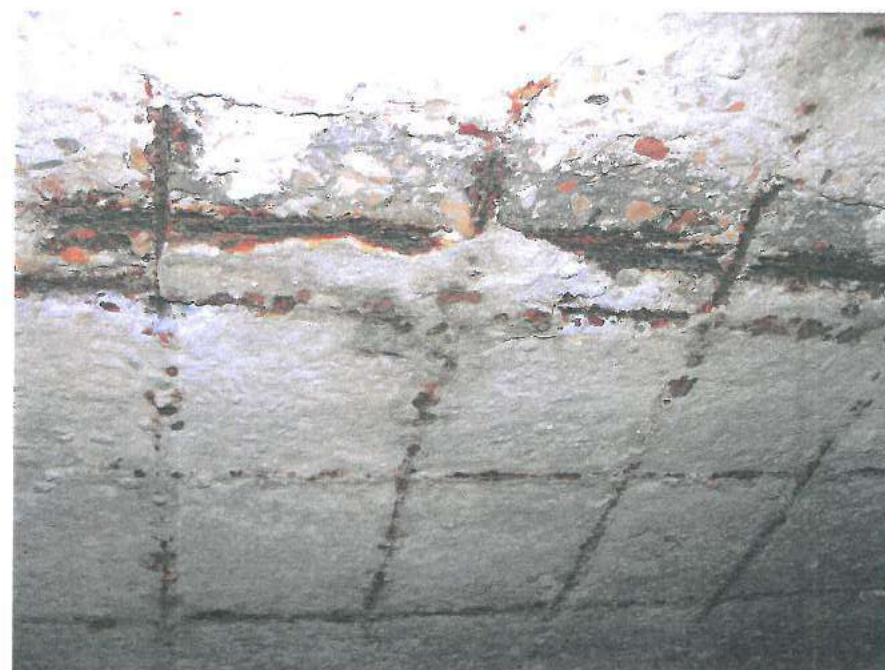
27.,28.att. Jumta konstrukciju tehniskais stāvoklis ir kritisks: paneļos un tekņēs konstatētas plaisas, stiegru atsegumi gan apakšējā, gan augšējā virsmā.
