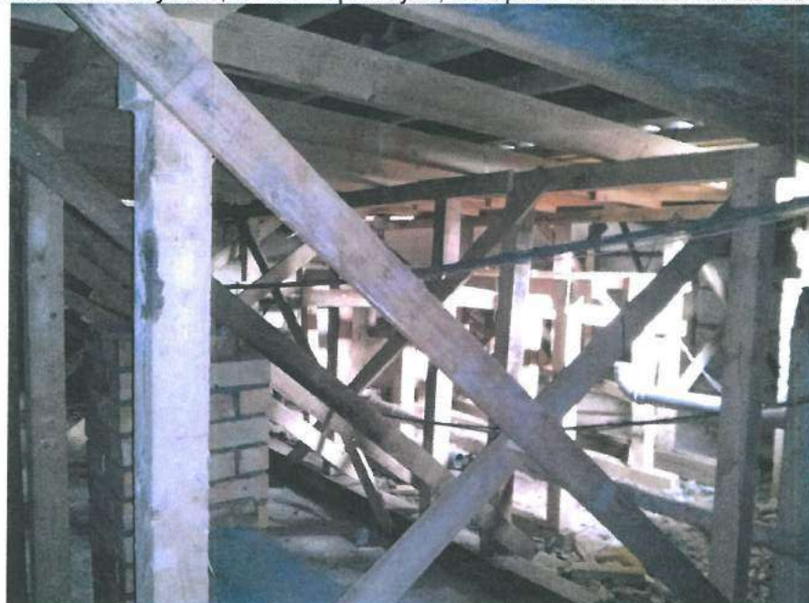
25., 26.att. Jumta paneļi dažās zonās demontēti kritiskā tehniskā stāvokļa dēļ – te ierīkots pagaidu jumts, kas balstās uz bēniņos izbūvēta koka karkasa.
