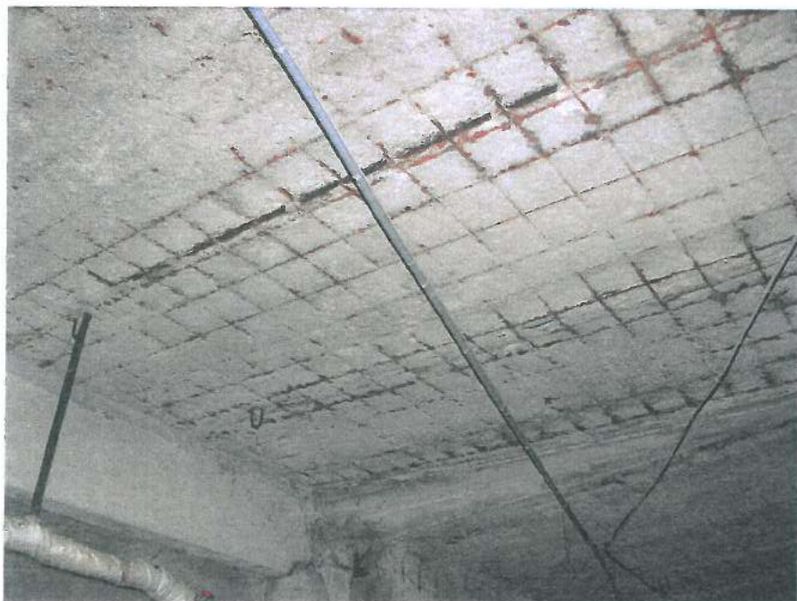
27.,28.att. Jumta konstrukciju tehniskais stāvoklis ir kritisks: paneļos un tekņēs konstatētas plaisas, stiegru atsegumi gan apakšējā, gan augšējā virsmā.
