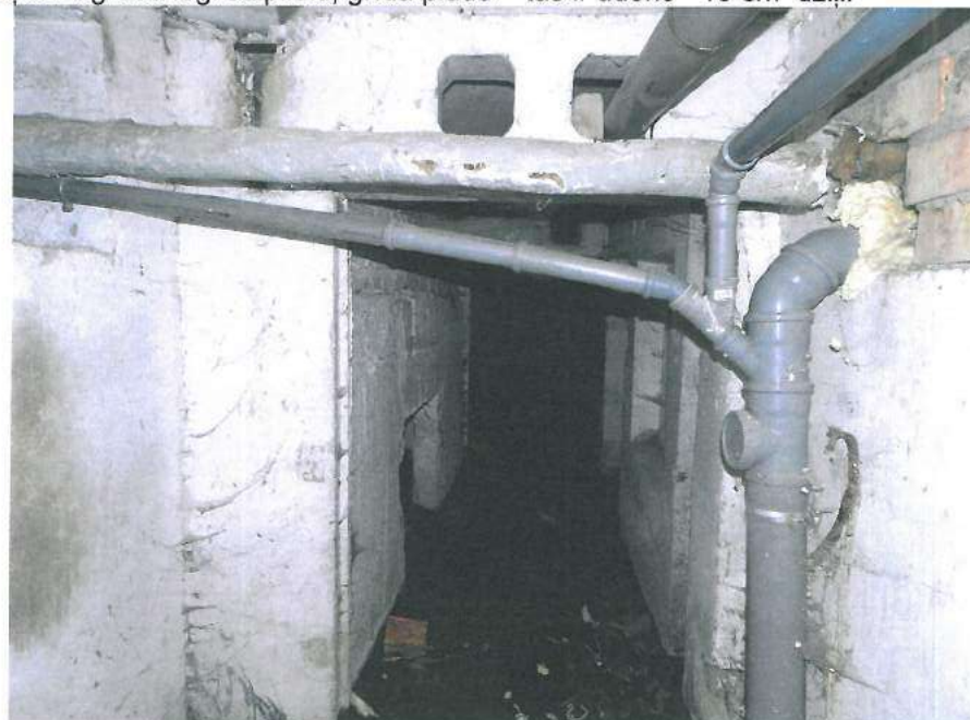
17.,18.att. Pagrabā jāveic inženiertīklu nomaiņa; sadzīves kanalizācija daļēji nomainīta. Uz grīdas ir ūdens ~10 cm dziļi; tas novērojams ilgstoša lietus laikā.
