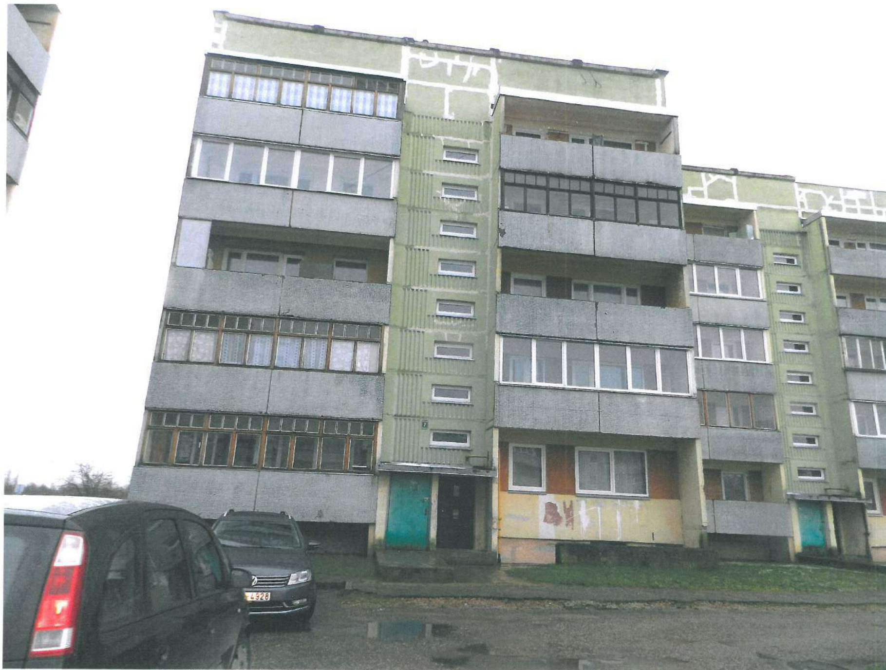
1.att. Dzīvojamā māja Aisteres ielā 7, Liepājā; ielas puses fasādes malējā sekcija.
