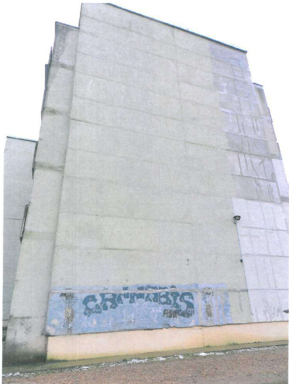
7.,8.att. Ē kas gala sienas. Redzami paneļu ārējās virsmas bojājumi.
