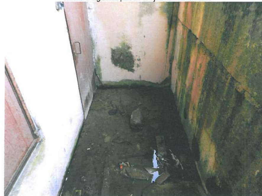
13., 14.att. Redzamas ieejas ēkas pagrabā; pie pagraba durvīm krājas lietuūdens; betona bloku atbalstsienas piesūkušās ar mitrumu.
