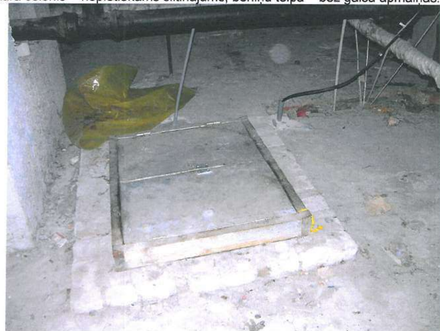
22.,23.att. Lūka uz bēniņiem neatbilst ugunsdrošības prasībām un ir jānomaina. Bēniņu pārsegums jāsilina pēc jauna jumta ierīkošanas.
