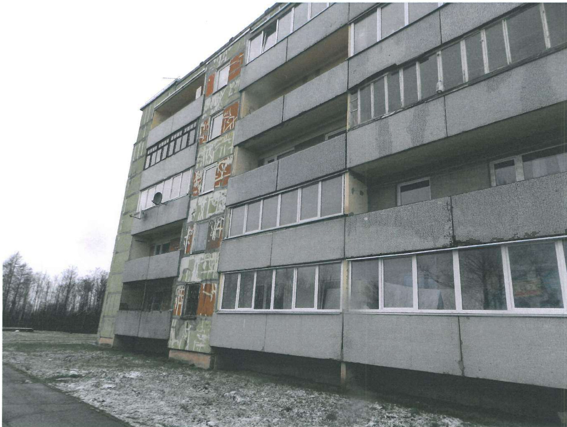
5.att. Dzīvojamā mājas dienvidu puses fasāde lodžijām, kurām paredzēts stiklojums ar „Sendvič” paneļu apakšējo joslu.
