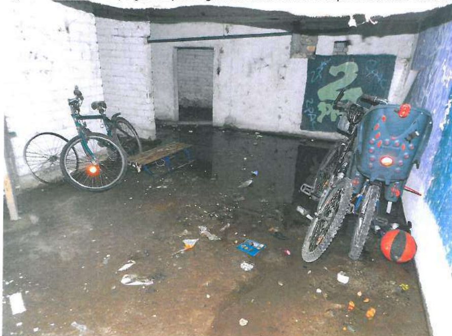
17.,18.att. Pagrabā jāveic inženiertīklu nomaiņa; sadzīves kanalizācija daļēji nomainīta. Uz grīdas ir ūdens ~10 cm dziļi; tas novērojams ilgstoša lietus laikā.
