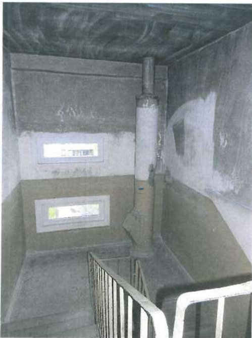
19.+21.att. Bēniņu pārsegumam nomelnējuši griesti kondensāta mitruma iespaidā, kura cēlonis - nepietiekams siltinājums; bēniņu telpa – bez gaisa apmaiņas.
