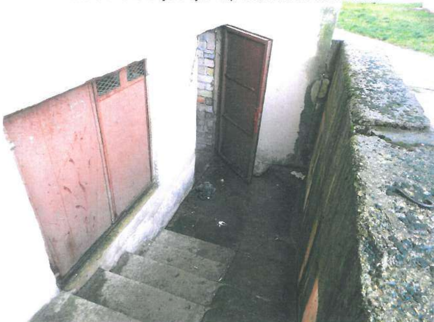
13., 14.att. Redzamas ieejas ēkas pagrabā; pie pagraba durvīm krājas lietuūdens; betona bloku atbalstsienas piesūkušās ar mitrumu.
