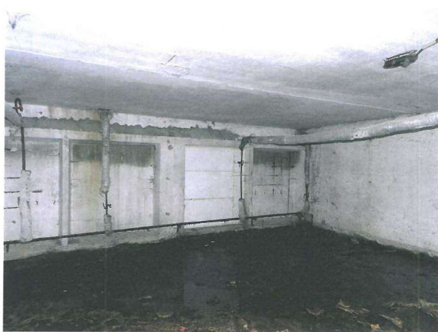
15.,16.att. Veicama pagraba pārseguma siltināšana no apakšas un inženiertīklu nomaiņa. Pagraba logi aizpildīti; grīda pludo – tās ir ūdens ~10 cm dziļi.
