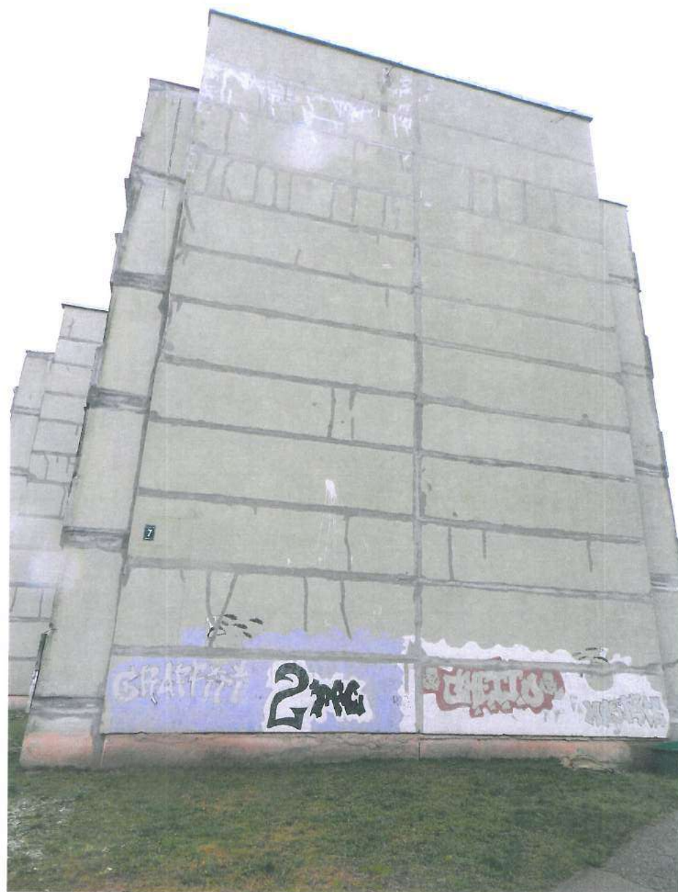
7.,8.att. Ē kas gala sienas. Redzami paneļu ārējās virsmas bojājumi.
