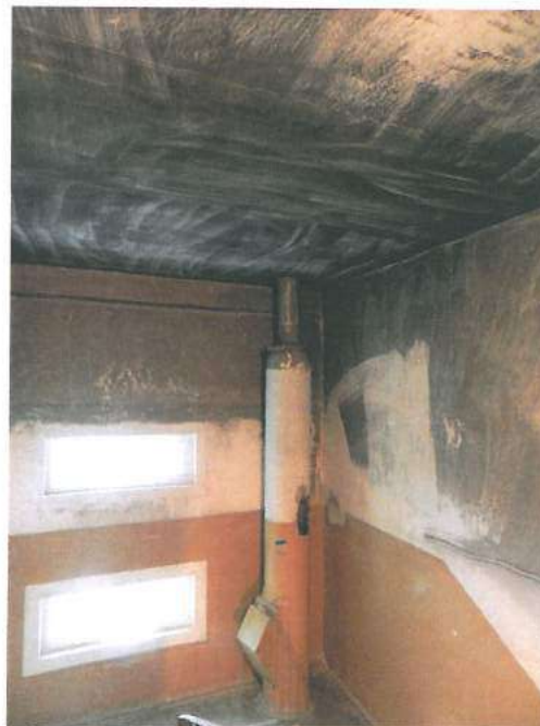
19.+21.att. Bēniņu pārsegumam nomelnējuši griesti kondensāta mitruma iespaidā, kura cēlonis - nepietiekams siltinājums; bēniņu telpa – bez gaisa apmaiņas.
