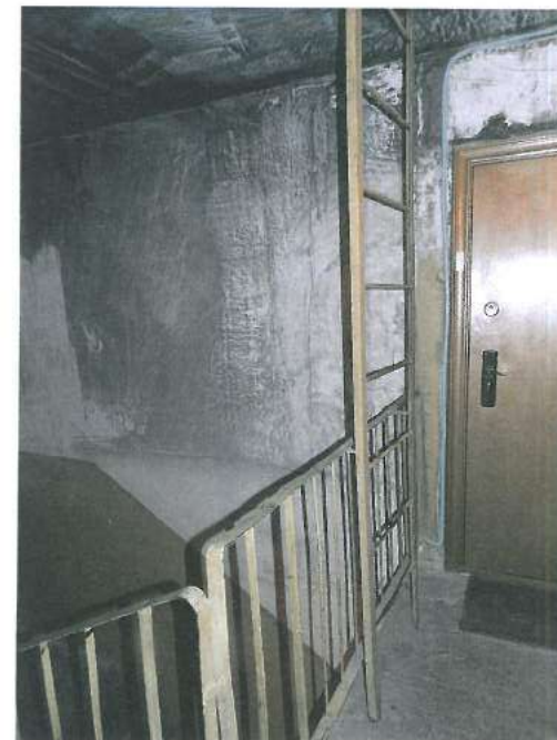
19.+21.att. Bēniņu pārsegumam nomelnējuši griesti kondensāta mitruma iespaidā, kura cēlonis - nepietiekams siltinājums; bēniņu telpa – bez gaisa apmaiņas.
