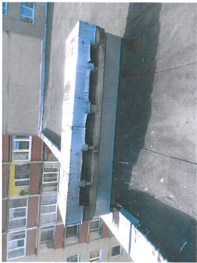
26.,27.att. Jumtam jāizbūvē margas; jāatjauno parapetu apšuvumi un vēdināšanas izvadu augšgali; jumts papildus jāsilina, jo esošais silinājums ir nepietiekams.
