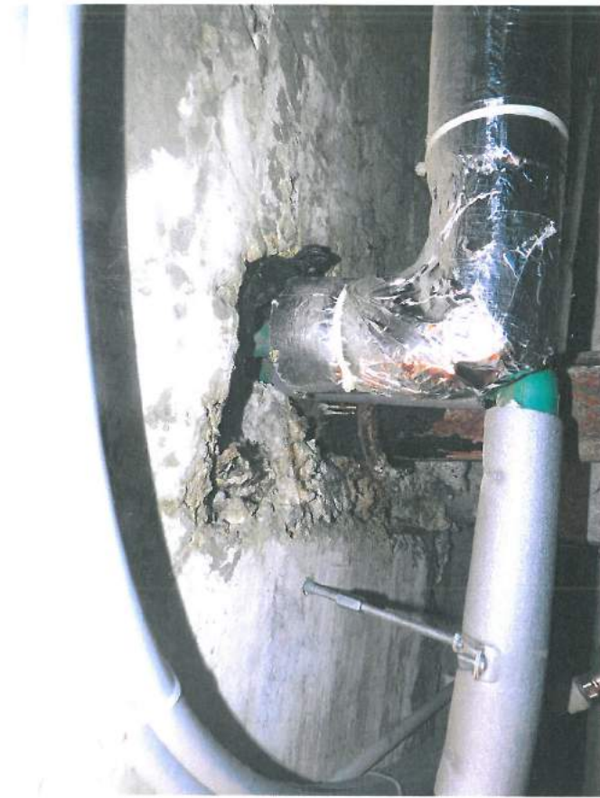
18., 19.att. Pagrabā esošie inženiertīkli nomainīti, izņemot apkuri. Līdz pagrabā pārseguma siltināšanas inženiertīkli jāatvērta no griestiem, jāaizpilda caurumi.
