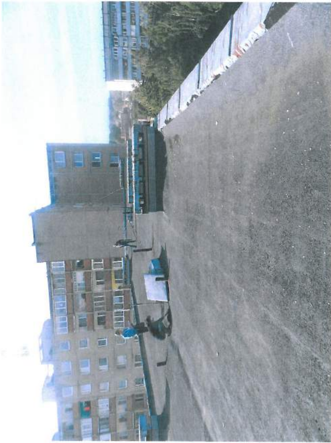
22.,23..att. Savietotā jumta seguma virsma līgana; daudz iedobumu, slīpums uz sateces vietām nepietiekams. Redzami savietotā jumta paneli ar vēdkanāliem .
