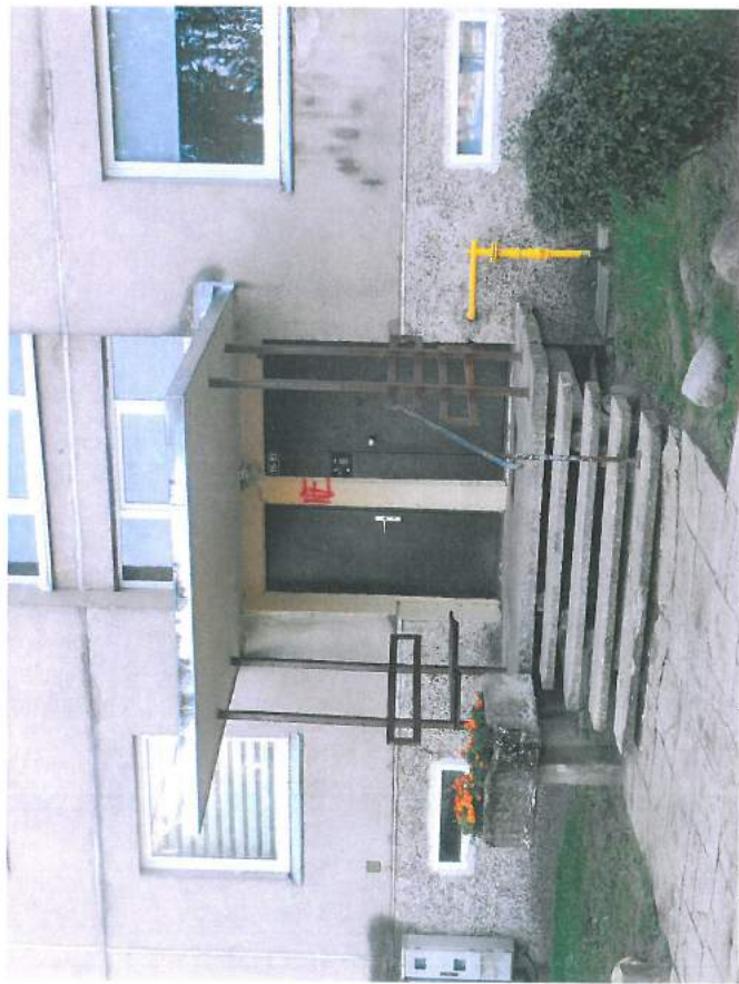
4., 5.att. Ieejas mezgli-no dzelzsbetona gatavelementiem; betona izdrupis pakāpienu plātnēm, puķu kastēm; laukumiem. Ūdens nēsšanas atvērumi aizplūdaņai.
