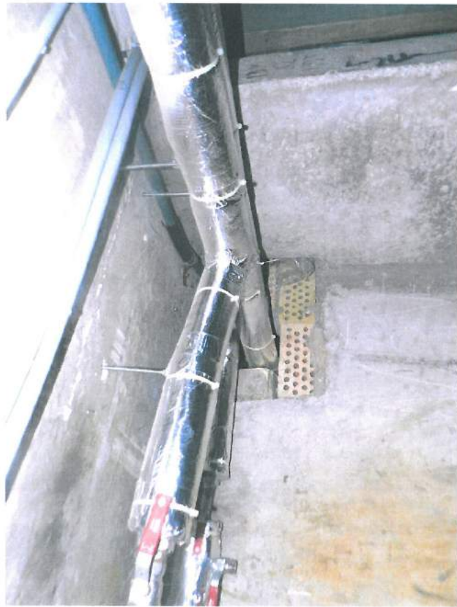
18., 19.att. Pagrabā esošie inženiertīkli nomainīti, izņemot apkuri. Līdz pagrabā pārseguma siltināšanas inženiertīkli jāatvērta no griestiem, jāaizpilda caurumi.
