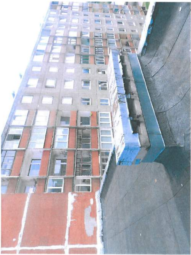
26.,27.att. Jumtam jāizbūvē margas; jāatjauno parapetu apšuvumi un vēdināšanas izvadu augšgali; jumts papildus jāsilina, jo esošais silinājums ir nepietiekams.
