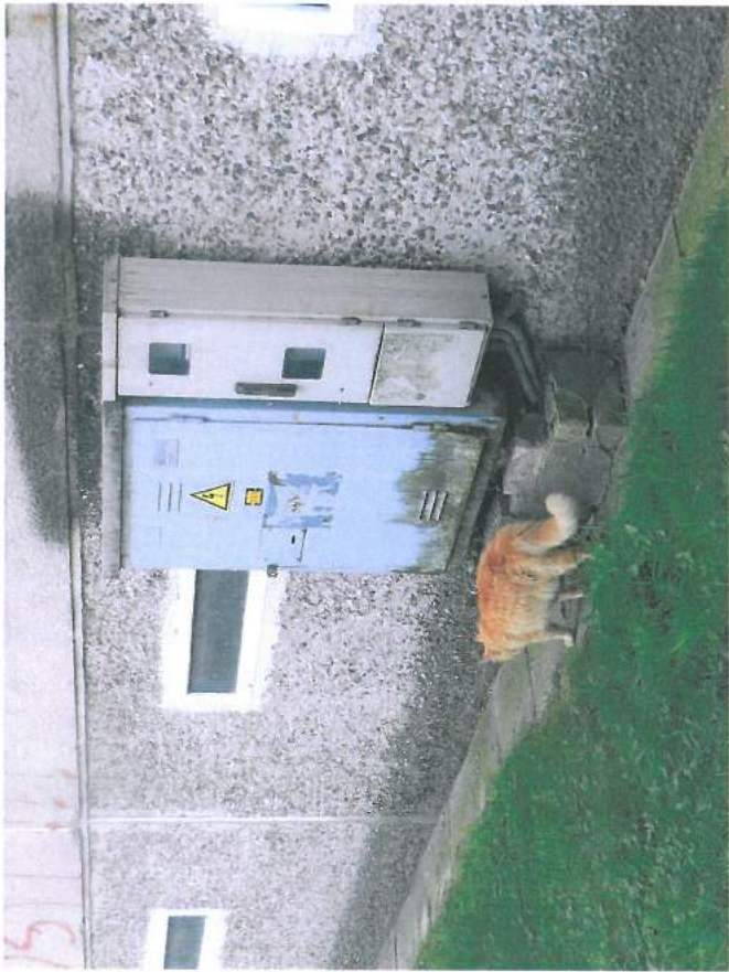
8., 9.att. Pirmsienu siltināšanas jāatvērza sadales skapji, gāze ievadi u.c. Vietām jāpazemina kultūrlānis, jārisina pagraba vēdināšana, jo logi ir neverami.
