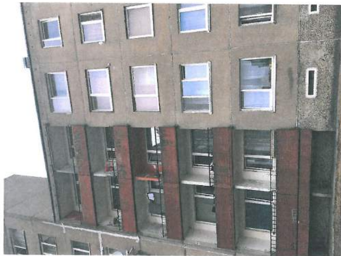
12., 13., 14. att. Lodžijas stiklotas atšķirīgi; daļa no tām nav stiklotas; apmale gar ēku jātīrauno. Pagraba logi neveram; vietām stikla vietā-aizpildījums.
