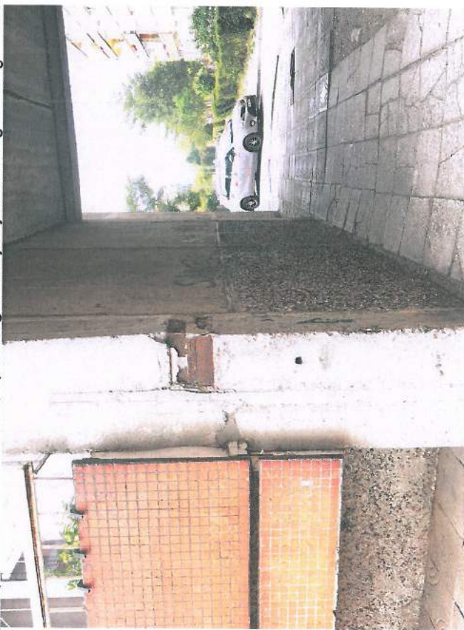
12., 13., 14. att. Lodžijas stiklotas atšķirīgi; daļa no tām nav stiklotas; apmale gar ēku jātīrauno. Pagraba logi neveram; vietām stikla vietā-aizpildījums.
