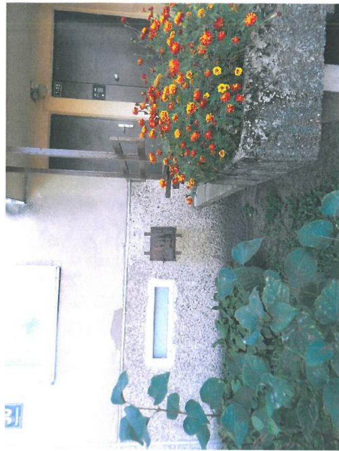
4., 5.att. Ieejas mezgli-no dzelzsbetona gatavelementiem; betona izdrupis pakāpienu plātnēm, puķu kastēm; laukumiem. Ūdens nēsšanas atvērumi aizplūdaņai.
