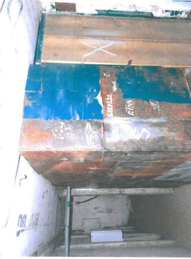
18., 19.att. Pagrabā esošie inženiertīkli nomainīti, izņemot apkuri. Līdz pagrabā pārseguma siltināšanas inženiertīkli jāatvērta no griestiem, jāaizpilda caurumi.
