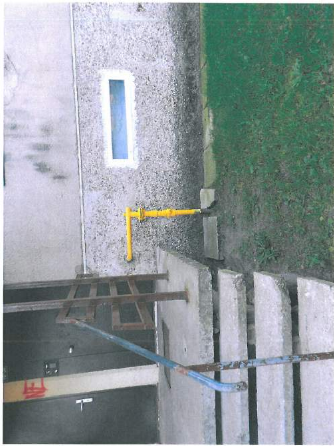
8., 9.att. Pirmsienu siltināšanas jāatvērza sadales skapji, gāze ievadi u.c. Vietām jāpazemina kultūrlānis, jārisina pagraba vēdināšana, jo logi ir neverami.
