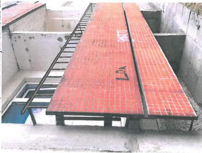
15. att. Lodžiju plātnes 15 cm izvirzītas uz āru.
