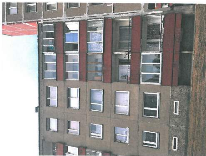
12., 13., 14. att. Lodžijas stiklotas atšķirīgi; daļa no tām nav stiklotas; apmale gar ēku jātīrauno. Pagraba logi neveram; vietām stikla vietā-aizpildījums.
