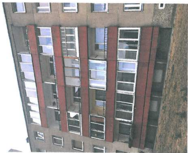
12., 13., 14. att. Lodžijas stiklotas atšķirīgi; daļa no tām nav stiklotas; apmale gar ēku jātīrauno. Pagraba logi neveram; vietām stikla vietā-aizpildījums.
