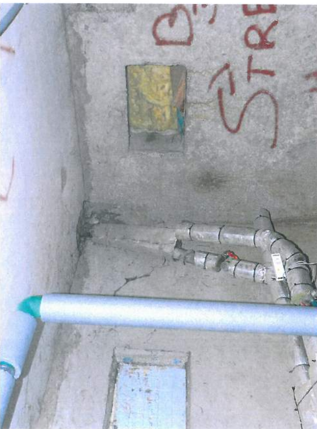
18., 19.att. Pagrabā esošie inženiertīkli nomainīti, izņemot apkuri. Līdz pagrabā pārseguma siltināšanas inženiertīkli jāatvērta no griestiem, jāaizpilda caurumi.
