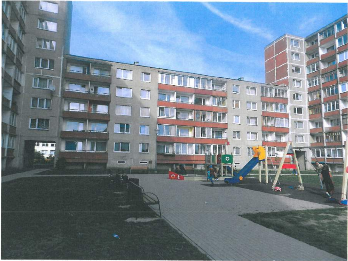
Dzīvojamā ēka E.Tisē ielā 50, Liepājā. Ēkas pagalma fasāde (dienvidu puse).
