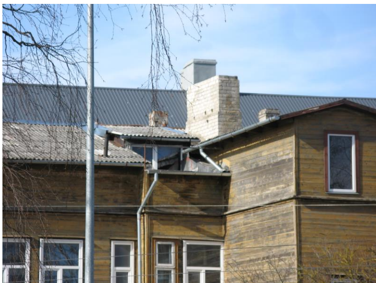
Austrumu fasāde ar jumta izbūvi un PVC logu bēniņu telpas izgaismošanai.
