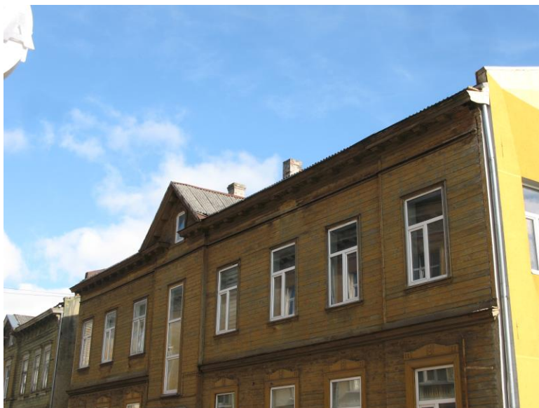
Jumta dzega ar dekoriem ēkas rietumu fasādē.
