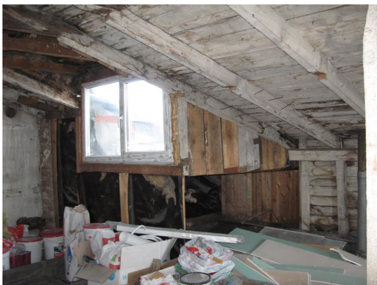
Jumta izbūve ar PVC logu austrumu fasādē.
