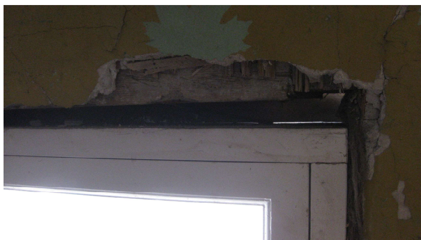
Foto Nr21 Loga konstrukcija ailā.
