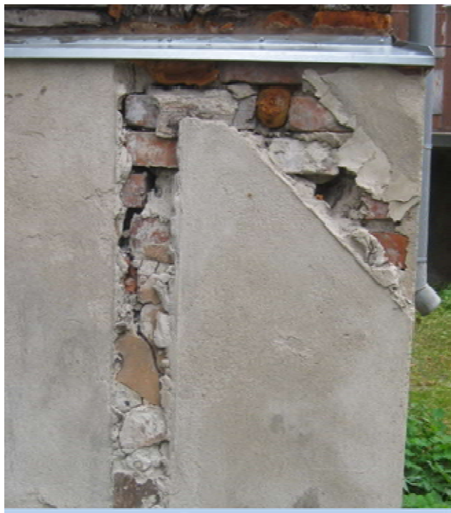
Foto Nr4 Ēkas pamatu virszemes daļa -plaisas mūrī, augšējā pamata daļa atdalījusies no mūra
