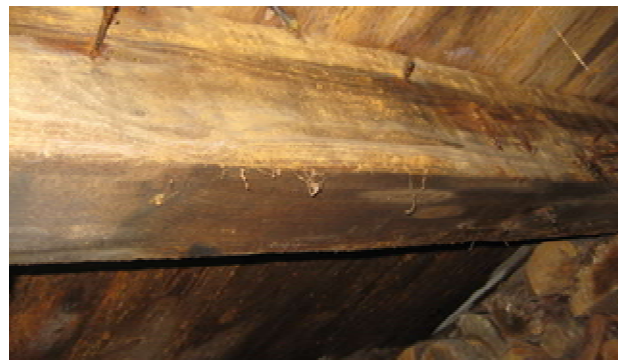
Foto Nr24 Cokolstāva pārseguma sijas un dēļu klājs
