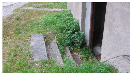
Foto Nr41 Pagalma puses pakāpieni uz cokolstāvu.
