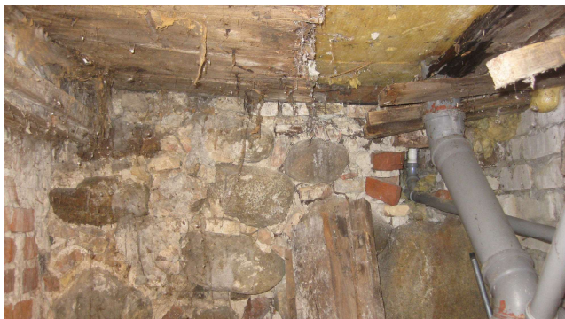
Foto Nr23 Cokolstāva pārsegums- iegruvusi grīda
