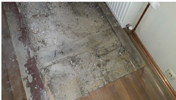
Foto Nr25.1 Pārseguma konstrukcijas atsegums 1.stāva dzīvoklī ielas pusē
