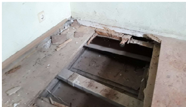
Foto Nr25.2 Pārseguma konstrukcijas atsegums 1.stāva dzīvoklī sētas pusē, metāla sijas
