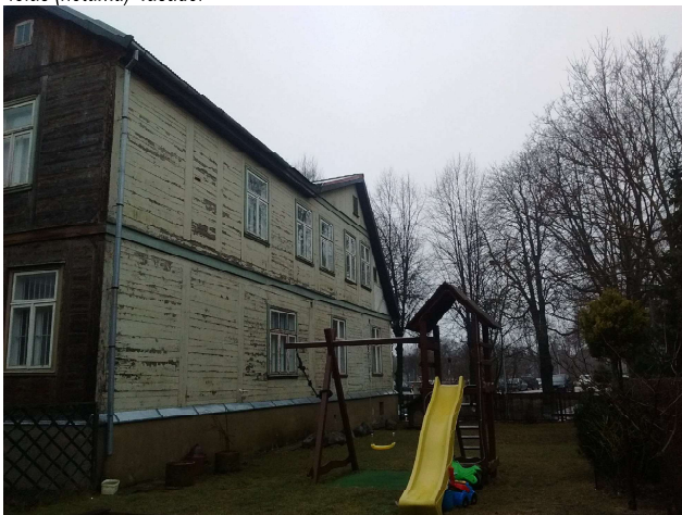
Foto Nr52 Ziemeļu fasāde
