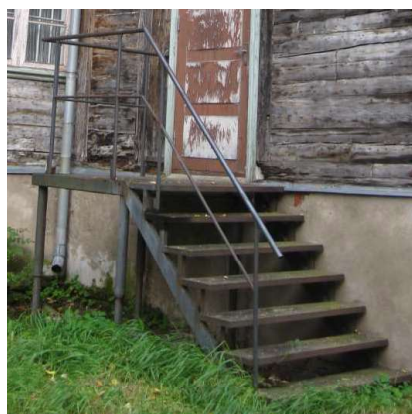
Foto Nr41 Pagalma puses kāpnes uz 1 stāvu.
