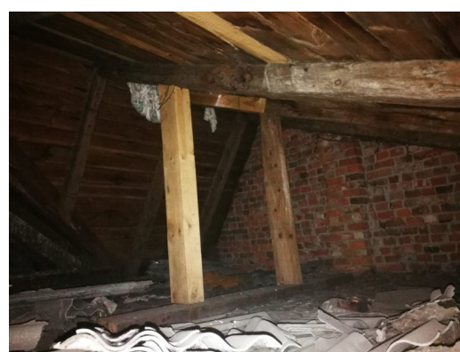
F – 3. Protezētas, labotas konstrukcijas. F – 4. Pārsegums virs dzīvokļa, jumta konstrukcijas.
