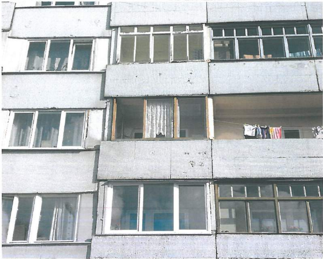
Ieeju jumtiņi (austrumu fasādē) - saliekamā dzelzsbetona plātnes bez speciālas apdares
