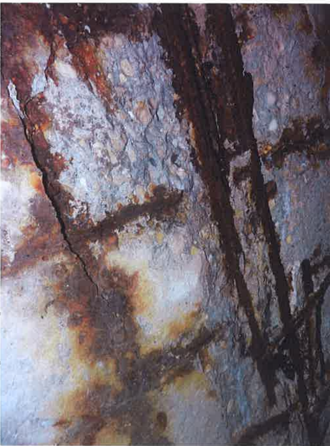
22., 23.att. Jumta paneļu apakšējā virsma mitruma bojāta plašos laukumos: konstatētas plaisas, stingru atsegumi, nomelnējums kondensāta mitruma iespaidā.
