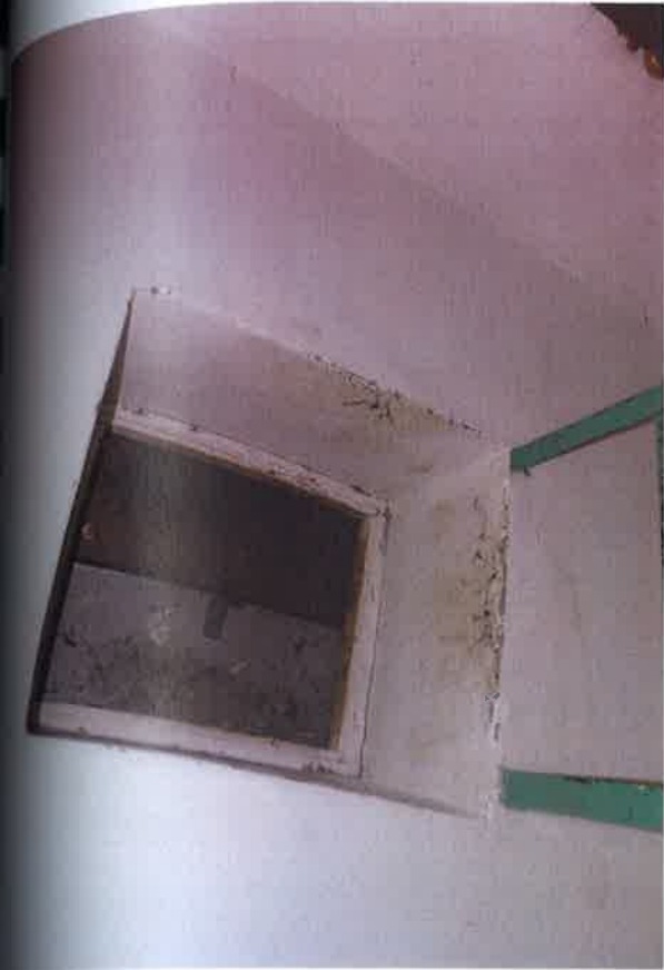
16., 17., 18.att. Ieejas bēniņos ierīkotas no visām kāpņu telpām caur lūku pārsegumā. Lūku vāki jānomaina uz ugunsdrošiem.
