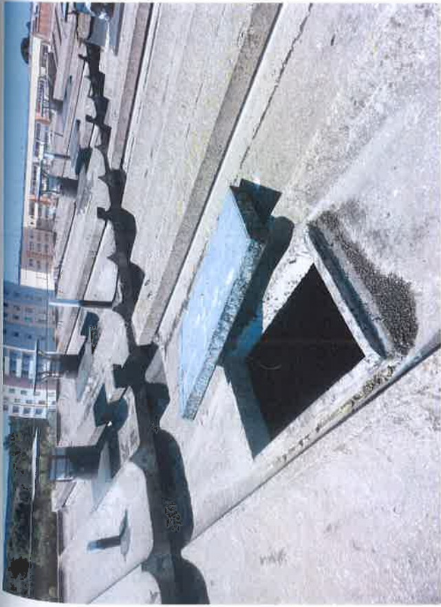
30., 31.att. Dzelzsbetona jumta kopskaits; visi jumta elementi-paneļi, jumtīni, margas, parapeti-deļēji nolietojušies; bojājumu vietas nosegtas ar ruberoīda lielāpiem.
