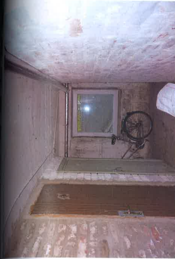
12., 13.att. Veicama pagraba pārseguma siltināšana; pagraba teļpes tīras. Pagraba logi nomainīti. Šķūņšiem pārsvartā mūrētas sienas; to augšdaļa būs jādemontē.
