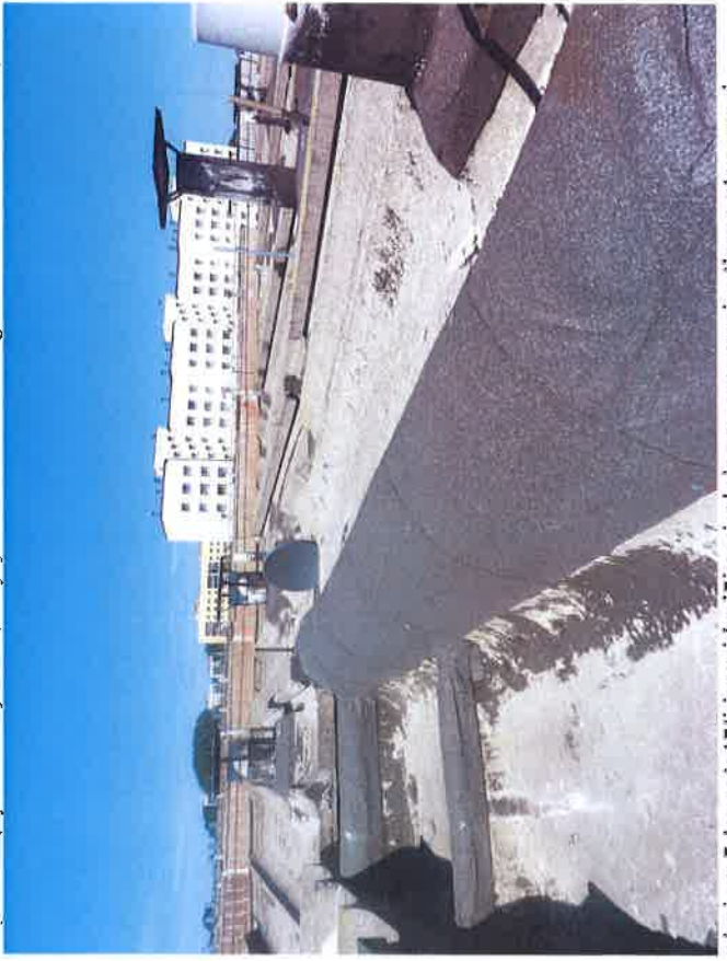
30., 31.att. Dzelzsbetona jumta kopskaits; visi jumta elementi-paneļi, jumtīni, margas, parapeti-deļēji nolietojušies; bojājumu vietas nosegtas ar ruberoīda lielāpiem.
