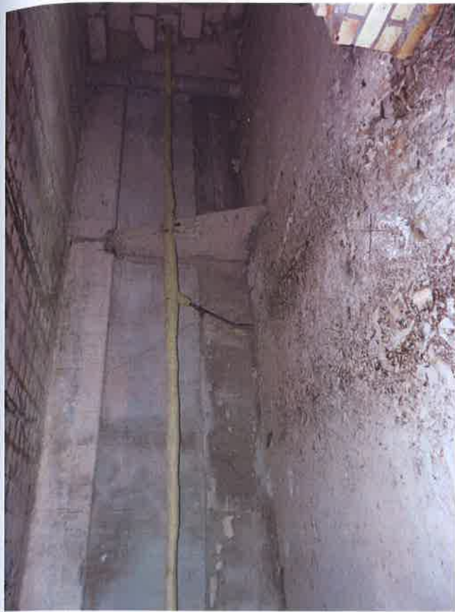
22., 23.att. Jumta paneļu apakšējā virsma mitruma bojāta plašos laukumos: konstatētas plaisas, stingru atsegumi, nomelnējums kondensāta mitruma iespaidā.
