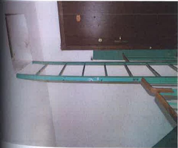
16., 17., 18.att. Ieejas bēniņos ierīkotas no visām kāpņu telpām caur lūku pārsegumā. Lūku vāki jānomaina uz ugunsdrošiem.
