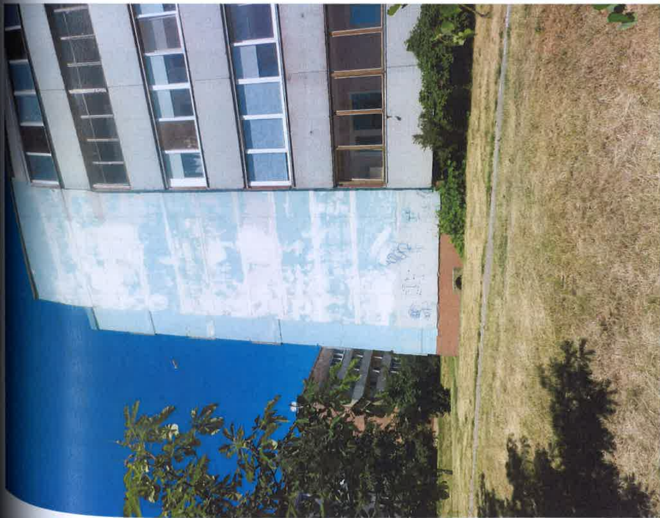
6., 7. att. Ē kas D puses āršienu izvizītie fragmenti ir mitruma bojāti; lodžiju stiklojums aizsargā āršienas no mitruma.
