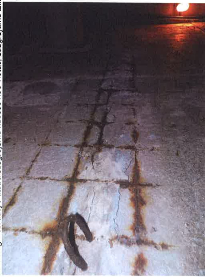
28.,29.att. Daudziem jumta paneļiem pēc betona aizsargkārtas nobiršanas atsegts sarūsējis stiegrojums, ir plaisas, mitruma plankumi caurumu zonās.
