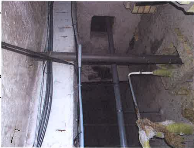
19., 20., 21.att. Bēniņu pārsegums jāsilvina pēc energoaudīta norādēm. Silvumtīkli tiks demontēti, lietussūdens notekcaurules nomainītas.
