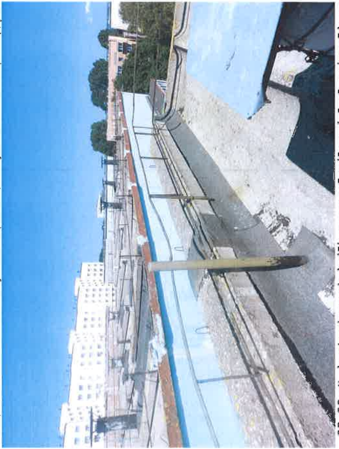
30., 31.att. Dzelzsbetona jumta kopskaits; visi jumta elementi-paneļi, jumtīni, margas, parapeti-deļēji nolietojušies; bojājumu vietas nosegtas ar ruberoīda lielāpiem.
