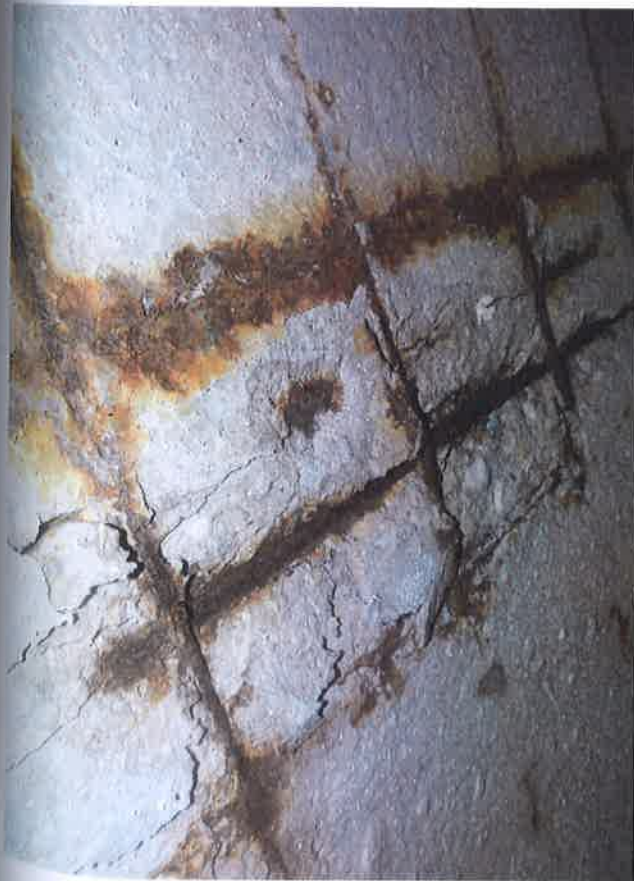
26.,27.att. Trijiem jumta paneļiem konstatēts kritisks stāvoklis: pēc betona nobiršanas atsegts sarūsējis darba stiegrojums nesošo ribu vietās; stiegrojums izliecies.
