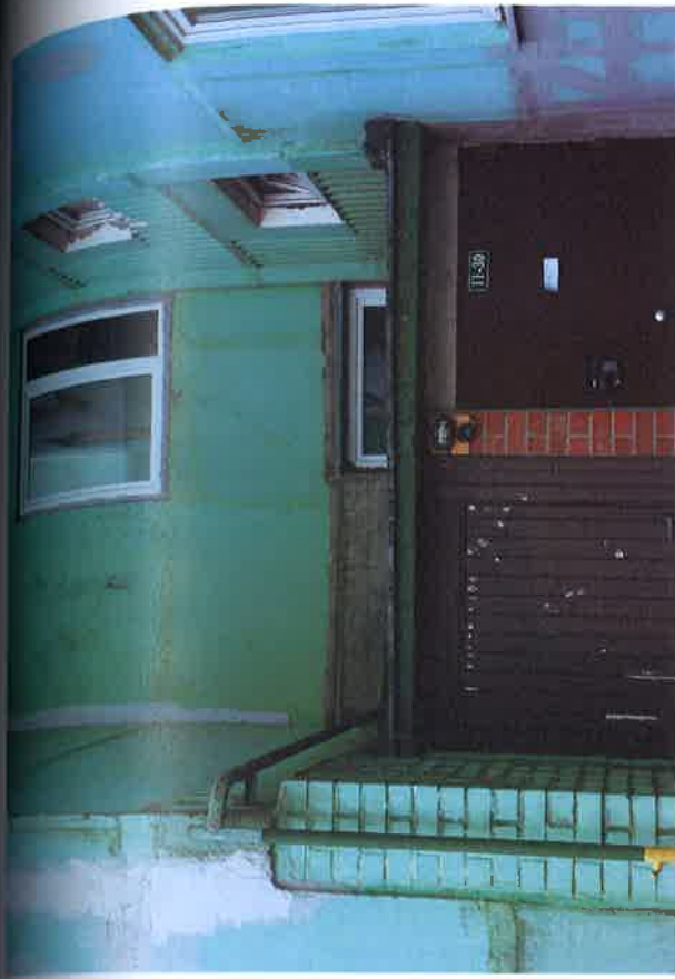
8., 9. att. Dzīvojamās mājas ārējo ieeju mezglu detaļas jāatjauno; ārdurvis ir nomainītas; 4. sekcijas jumtiņu vēlams pagarināt.
