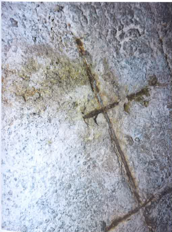
22., 23.att. Jumta paneļu apakšējā virsma mitruma bojāta plašos laukumos: konstatētas plaisas, stingru atsegumi, nomelnējums kondensāta mitruma iespaidā.
