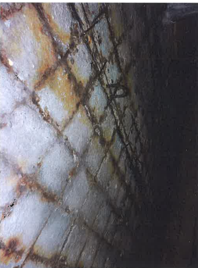
22., 23.att. Jumta paneļu apakšējā virsma mitruma bojāta plašos laukumos: konstatētas plaisas, stingru atsegumi, nomelnējums kondensāta mitruma iespaidā.
