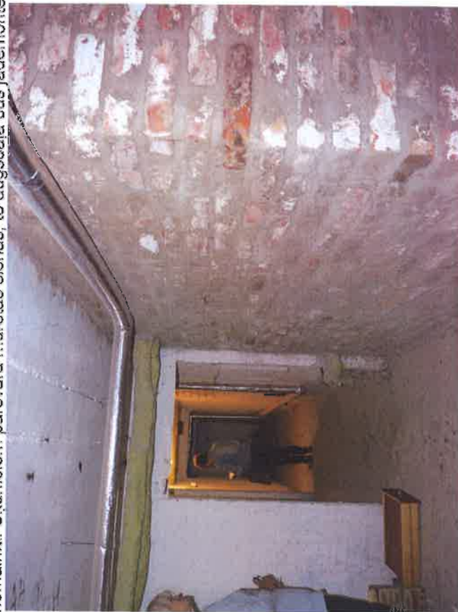
12., 13.att. Veicama pagraba pārseguma siltināšana; pagraba teļpes tīras. Pagraba logi nomainīti. Šķūņšiem pārsvartā mūrētas sienas; to augšdaļa būs jādemontē.
