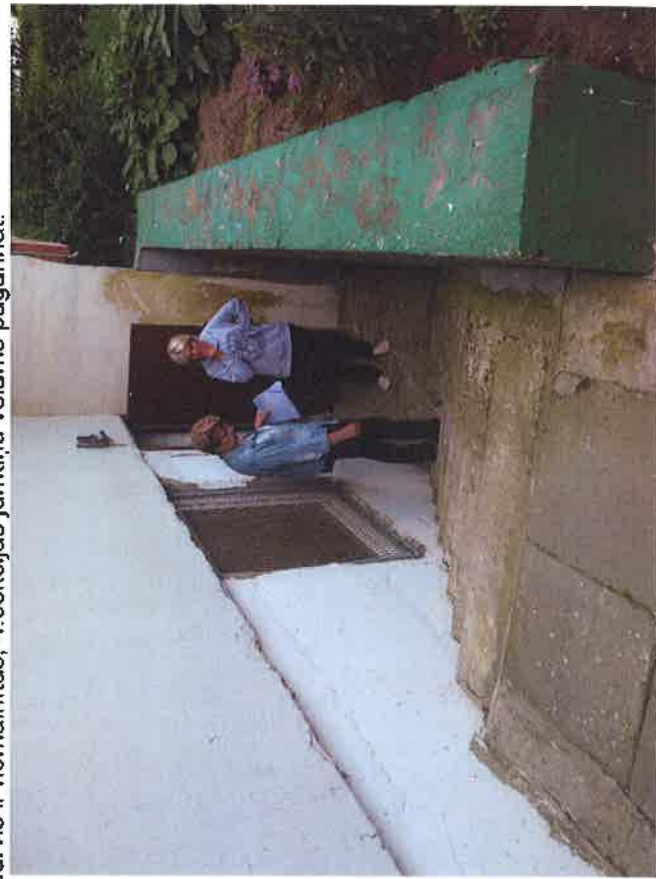
10., 11. att. Betona apmale ierīkota tikai pie izvirzītajām ār sienām. Pagraba ieejām jānomaina ārdurvis; jāatjauno pakāpienu un atbalsts virsma.
