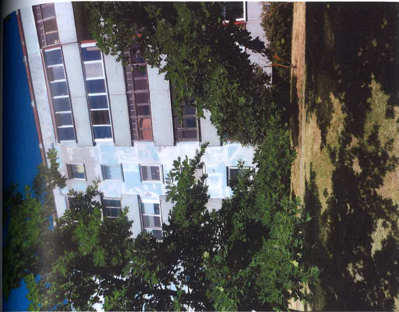
6., 7. att. Ē kas D puses āršienu izvizītie fragmenti ir mitruma bojāti; lodžiju stiklojums aizsargā āršienas no mitruma.
