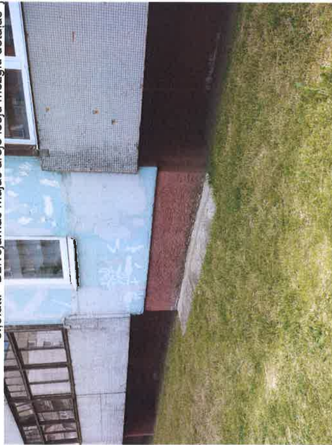
10., 11. att. Betona apmale ierīkota tikai pie izvirzītajām ār sienām. Pagraba ieejām jānomaina ārdurvis; jāatjauno pakāpienu un atbalsts virsma.
