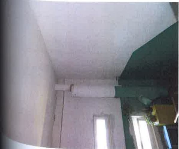
16., 17., 18.att. Ieejas bēniņos ierīkotas no visām kāpņu telpām caur lūku pārsegumā. Lūku vāki jānomaina uz ugunsdrošiem.
