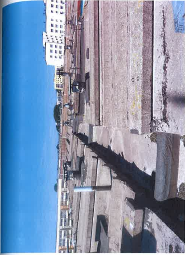
30., 31.att. Dzelzsbetona jumta kopskaits; visi jumta elementi-paneļi, jumtīni, margas, parapeti-deļēji nolietojušies; bojājumu vietas nosegtas ar ruberoīda lielāpiem.
