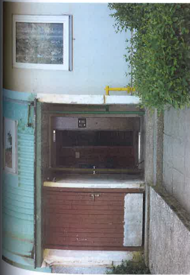
8., 9. att. Dzīvojamās mājas ārējo ieeju mezglu detaļas jāatjauno; ārdurvis ir nomainītas; 4. sekcijas jumtiņu vēlams pagarināt.
