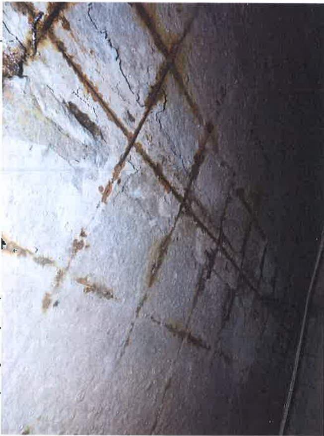
28.,29.att. Daudziem jumta paneļiem pēc betona aizsargkārtas nobiršanas atsegts sarūsējis stiegrojums, ir plaisas, mitruma plankumi caurumu zonās.
