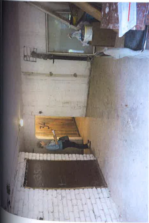
12., 13.att. Veicama pagraba pārseguma siltināšana; pagraba teļpes tīras. Pagraba logi nomainīti. Šķūņšiem pārsvartā mūrētas sienas; to augšdaļa būs jādemontē.
