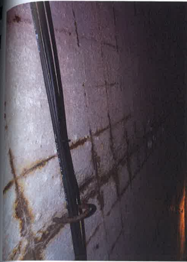
26.,27.att. Trijiem jumta paneļiem konstatēts kritisks stāvoklis: pēc betona nobiršanas atsegts sarūsējis darba stiegrojums nesošo ribu vietās; stiegrojums izliecies.
