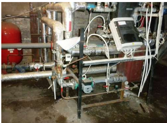
Rekonstruēts siltummezgls ēkas pagrabā 31. Pagrabs
