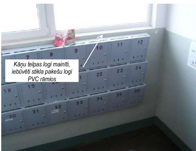
Kāpņu telpas interjers 47. Kāpņu telpa
