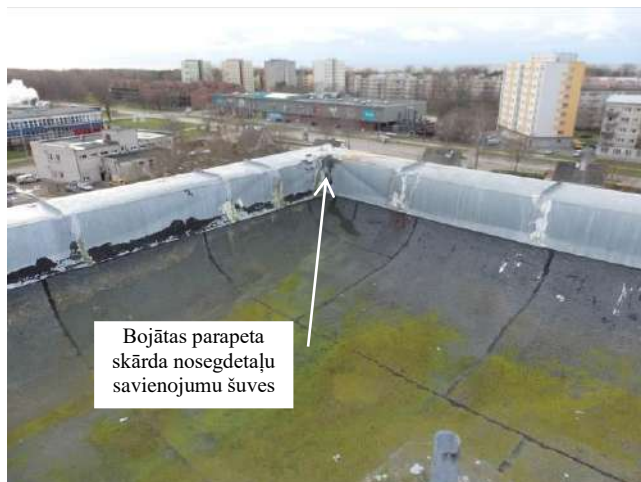
Jumta parapetu nosēgskārda detaļas
