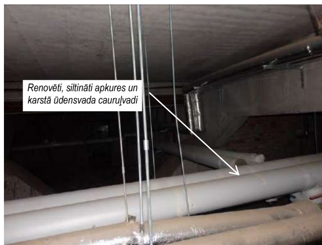
Veikta esošo kanalizācijas cauruļvadu nomainīšana. Renovēti, siltināti apkures un karstā ūdensvada cauruļvadi. 33. Pagrabs
