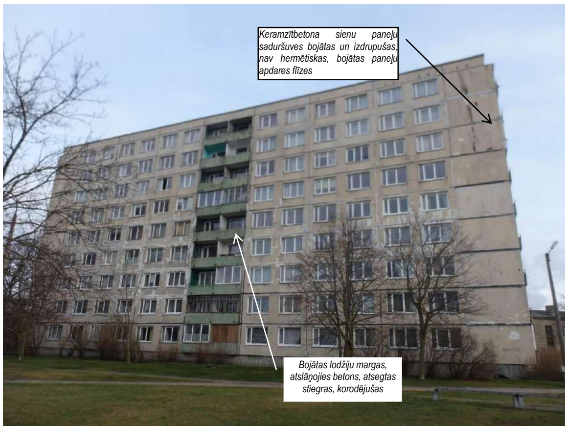
16. Rietumu fasādes kopskats
