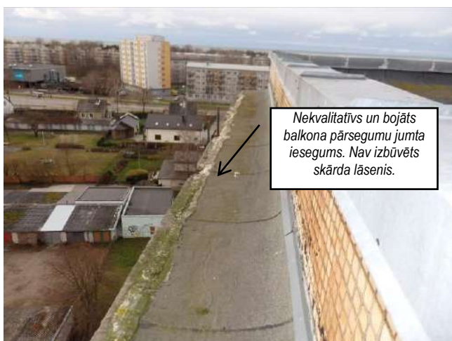
Bojāts un nolietojies balkonu pārsegumu jumta segums, vēdināšanas kanālu nosēgumtiņi
