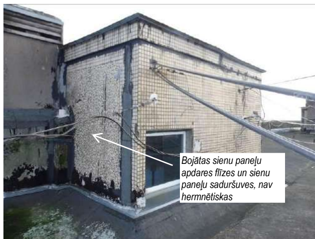
Bojāts un nolietojies balkonu pārsegumu jumta segums, vēdināšanas kanālu nosēgumtiņi
