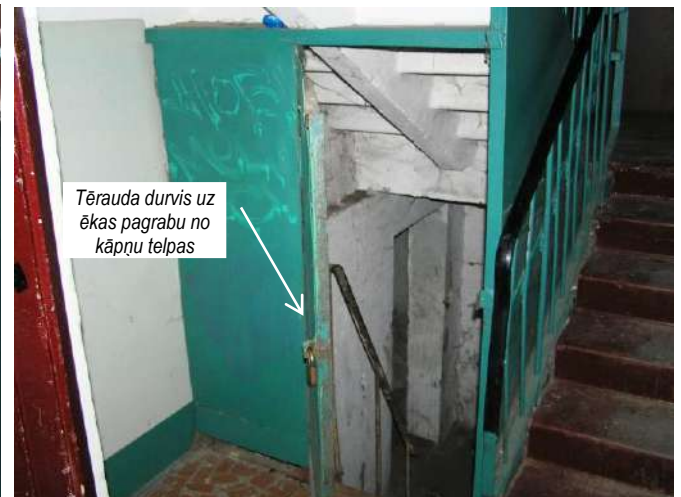
Durvis uz ēkas pagrabu 44. Kāpņu telpa
