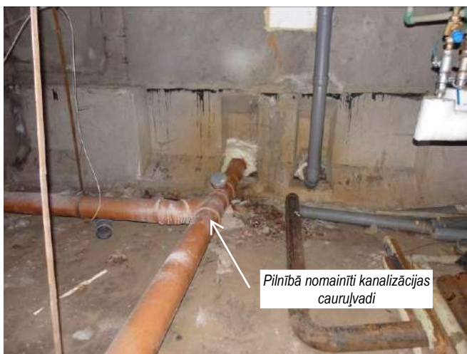
Veikta esošo kanalizācijas cauruļvadu nomainīšana. Renovēti, siltināti apkures un karstā ūdensvada cauruļvadi. 33. Pagrabs
