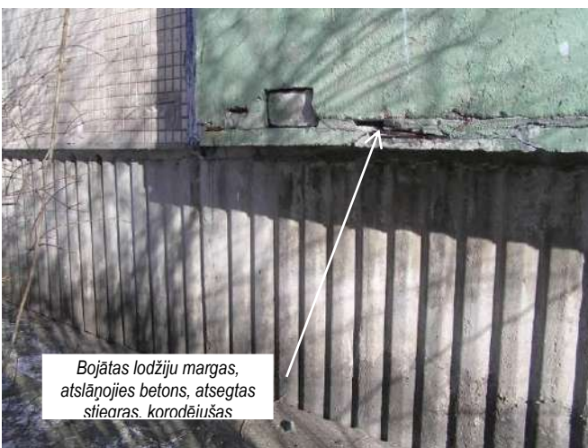
Bojāti balkonu pārsegumu un margu paneļi, bojātas un nodrupušas sienu paneļu apdares flīzes, bojātas un izdrupušas paneļu saduršuves, nav hermētiskas 23. Rietumu fasādes fragments
