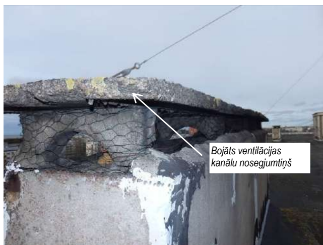
Bojāts un nolietojies balkonu pārsegumu jumta segums, vēdināšanas kanālu nosēgumtiņi
