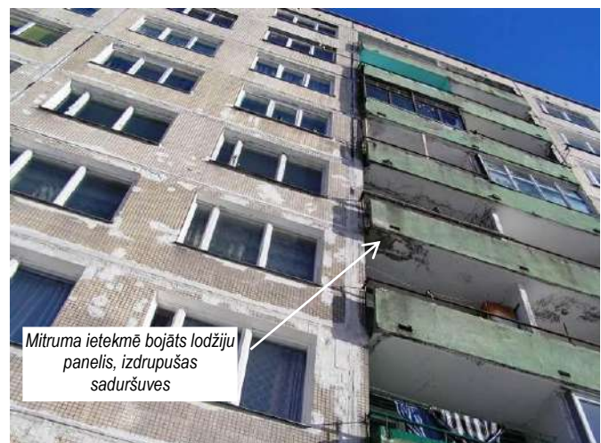
Bojāti balkonu pārsegumu un margu paneļi, bojātas un nodrupušas sienu paneļu apdares flīzes, bojātas un izdrupušas paneļu saduršuves, nav hermētiskas 23. Rietumu fasādes fragments
