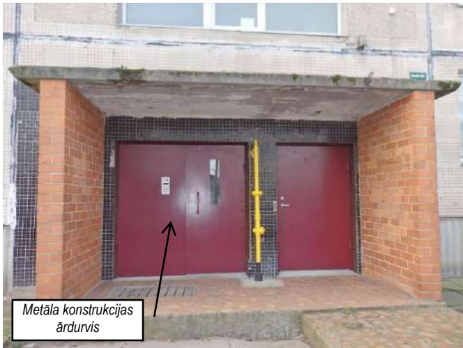
Ēkas ieejas durvis coka konstrukcijas 4. Austrumu fasādes fragments
