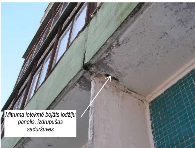
Bojātas lodžiju margas, lodžiju pārsegumu paneli, sienu paneli. Izdrupušas un bojātas lodžiju pārsegumu un lodžiju atdalošo sienu paneļu saduršuves
