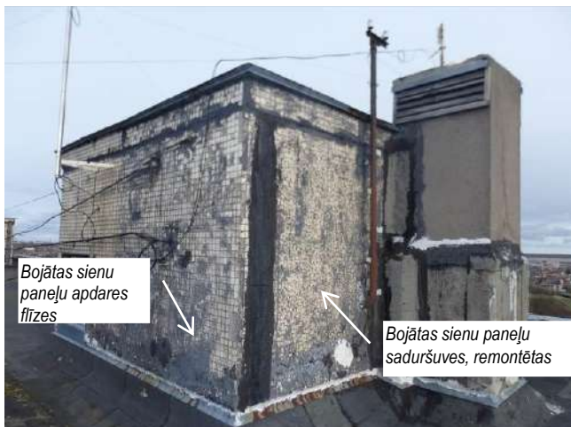
Lifta mašīntelpas jumta izbūve, vēdināšanas kanālu izvads
