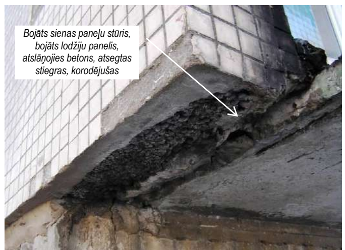
Bojātas lodžiju margas, lodžiju pārsegumu paneli, sienu paneli. Izdrupušas un bojātas lodžiju pārsegumu un lodžiju atdalošo sienu paneļu saduršuves
