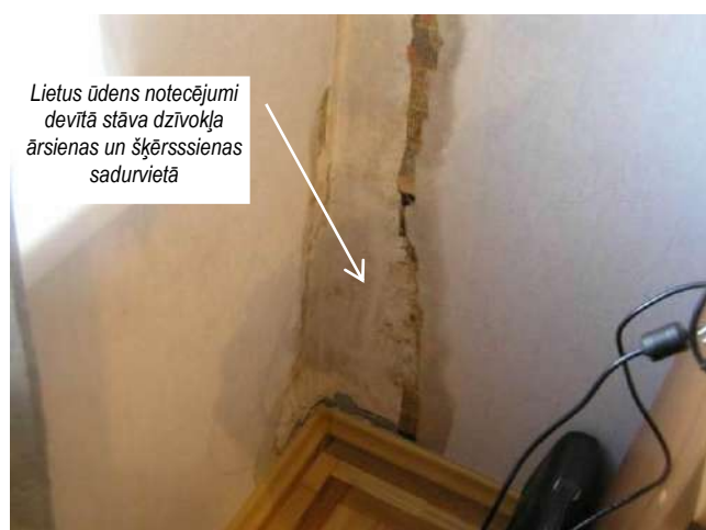
Devītā stāva dzīvokļu griestos, kā arī ār sienas un šķērssienu sadurvietā lietus ūdens notecējumi no ēkas jumta
