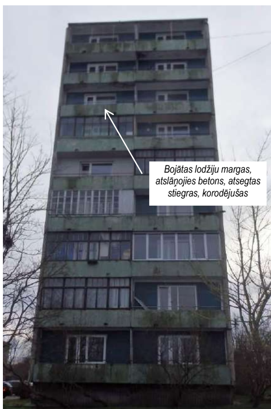
17. Ziemeļu fasādes kopskats
