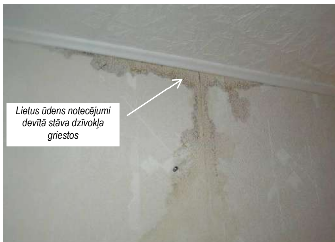
Devītā stāva dzīvokļu griestos, kā arī ār sienas un šķērssienu sadurvietā lietus ūdens notecējumi no ēkas jumta
