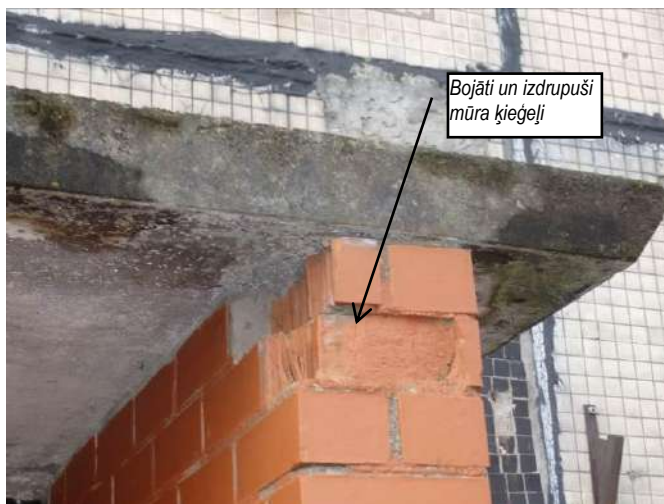
Bojāts ķieģeļu mūris zem ieejas jumtiņa 6. Austrumu fasādes fragments
