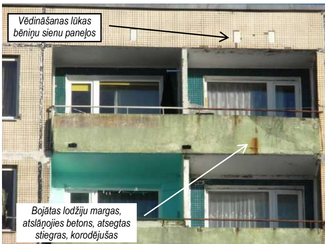
Bojāti lodžiju pārsegumu un margu paneļi 19. Rietumu fasādes fragments
