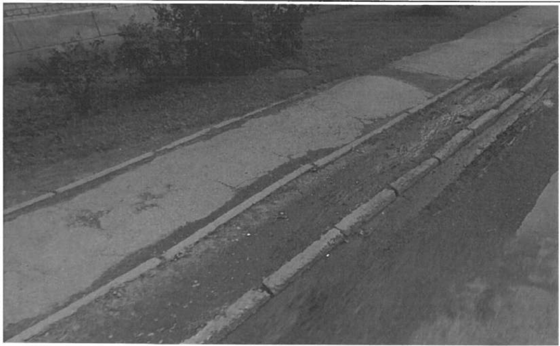
1. att. Apsekojamās ēkas ielas puse
