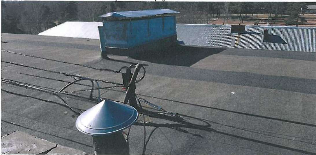
10.att Jumta segums.
