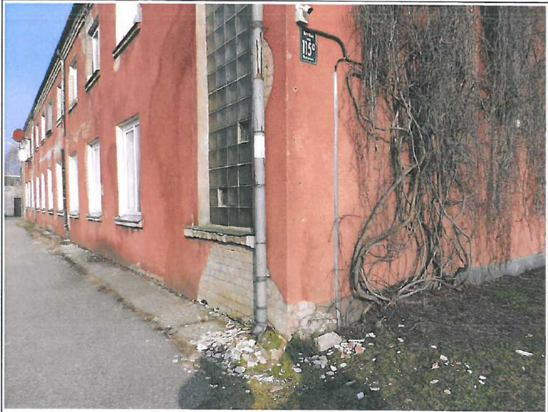
1. att. Apsekojamās ēkas ielas puse
