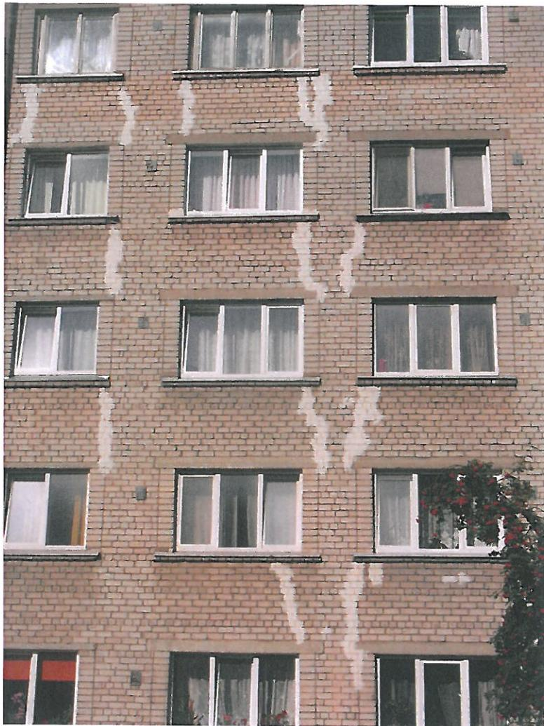
Nemot vērā, ka esošās deformācijas visas ēkas stabilitāti un noturību maz iespaido, pamati kopumā vērtējami kā labā tehniskā stāvoklī. Taču tas neizslēdz nepieciešamību fiksēt visas plāisas un novērot to veidošanās dinamiku vismaz reizi gadā.
