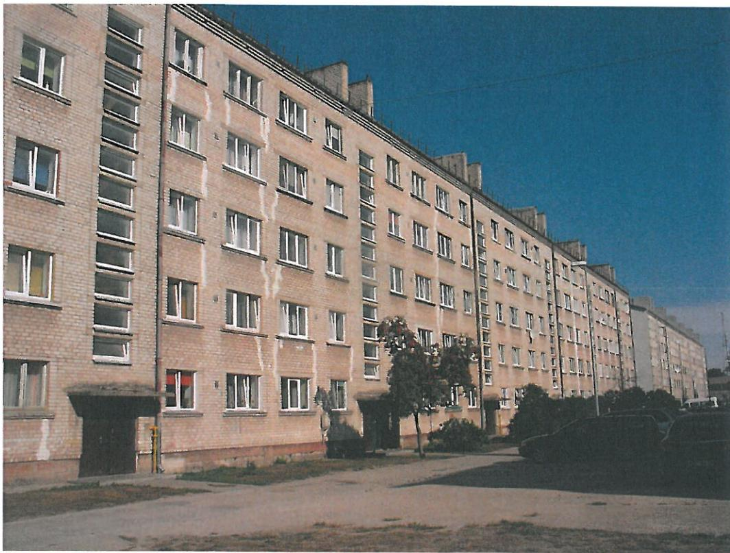
Dzīvojamai mājai ir tehniskais pagrabs, tehniskie bēniņi un jumts ar ārējo lietus ūdens novadīšanas sistēmu. 56 dzīvokļi ir ar balkoniem rietumu fasādē. Telpu augstums  $H=2.50\text{m}$ . Tehniskajā pagrabā visi galvenie inženierkomunikāciju maģistrālie cauruļvadi izvietoti tehniskajā koridorā gar ēkas rietumu fasādi.
