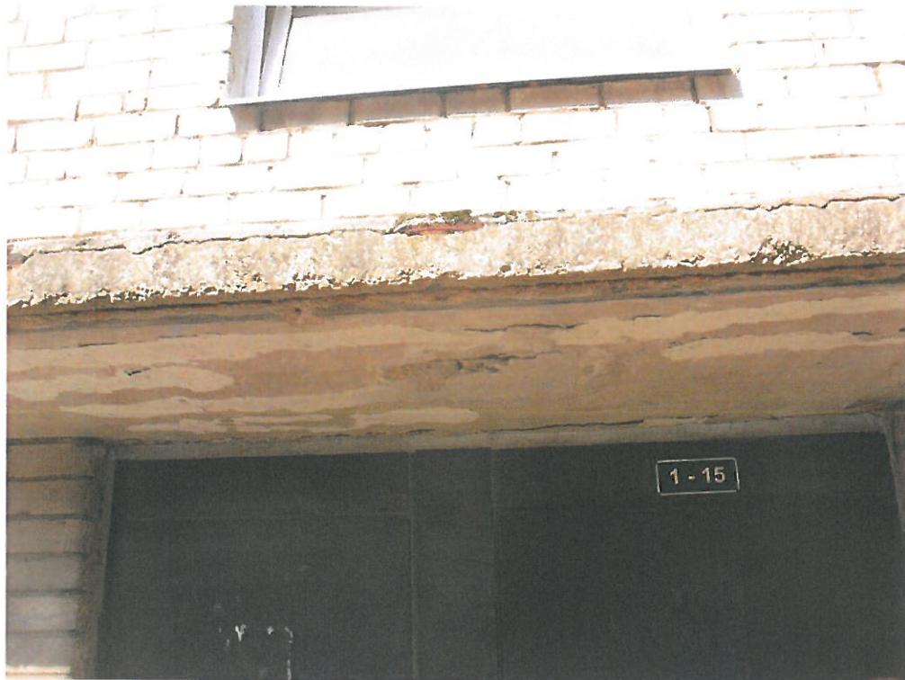
Lieveni – betona brūgīs. Labā tehniskā stāvoklī.
