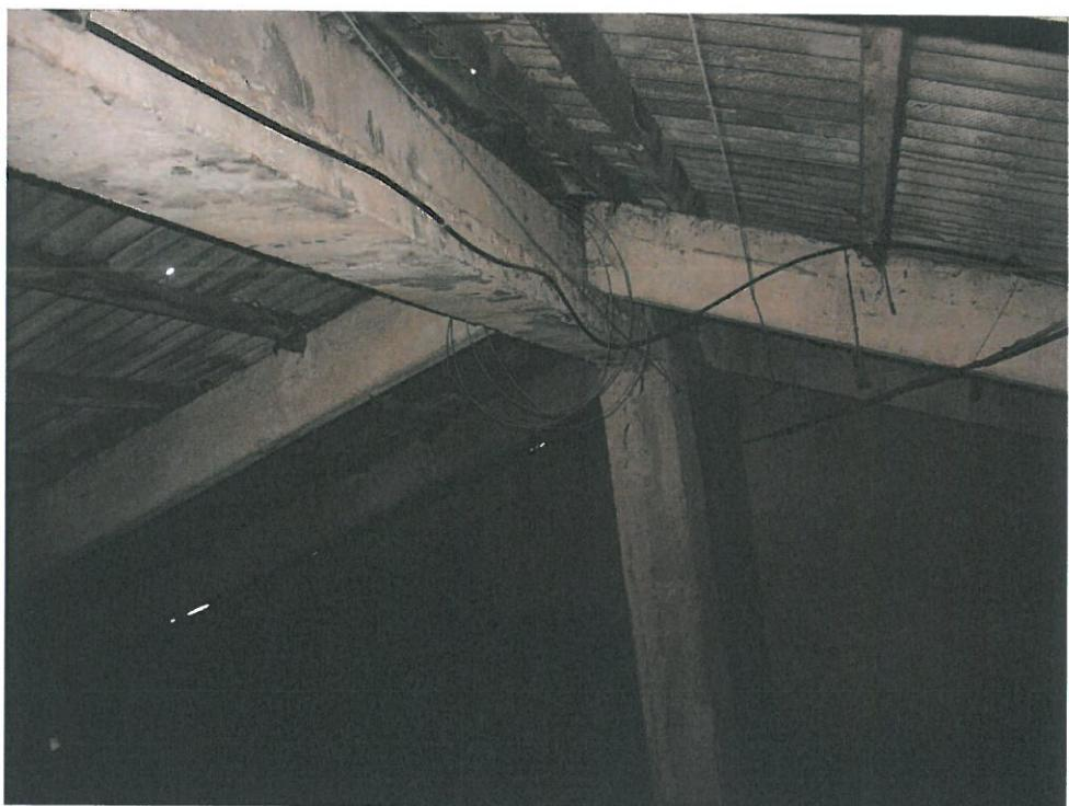
Visi karkasa elementi bez būtiskiem defektiem, plaisām un izdrupumiem, labā tehniskā stāvoklī.
