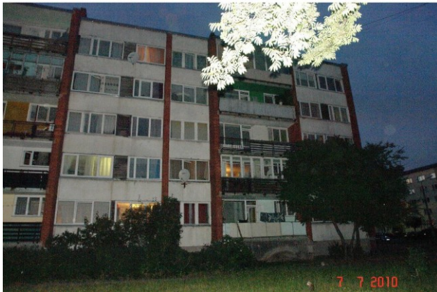
Ēkas Dienvidu fasāde
